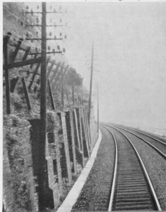
▼ Abb. 11. Diese Masten an der Kurven-Innenseite (Strecke Trier — Koblenz nahe Cochem) sind zusätzlich an der Stützmauer und am Hang befestigt. Man beachte auch das Steinschlag-Schutzgatter.
