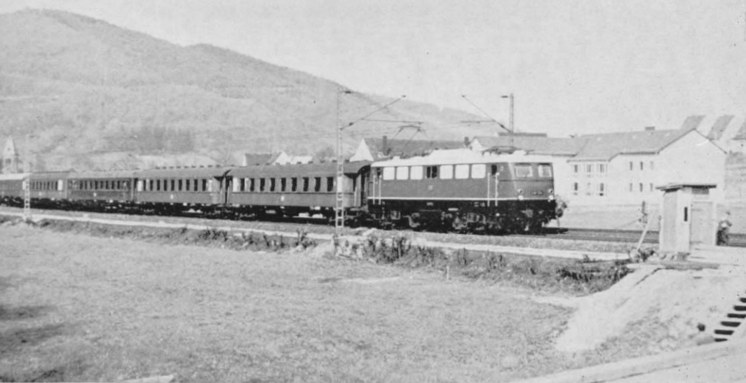
Abb. 20. Im Jahre 1965 aufgenommen: eine E 40 mit einem Eil- (oder Nahverkehrs-)Zug aus mehreren Vorkriegs-Typen. Der dritte und vierte Wagen sind Schürzenwagen. (Foto: Dr. R. Brüning, Bruchköbel)
