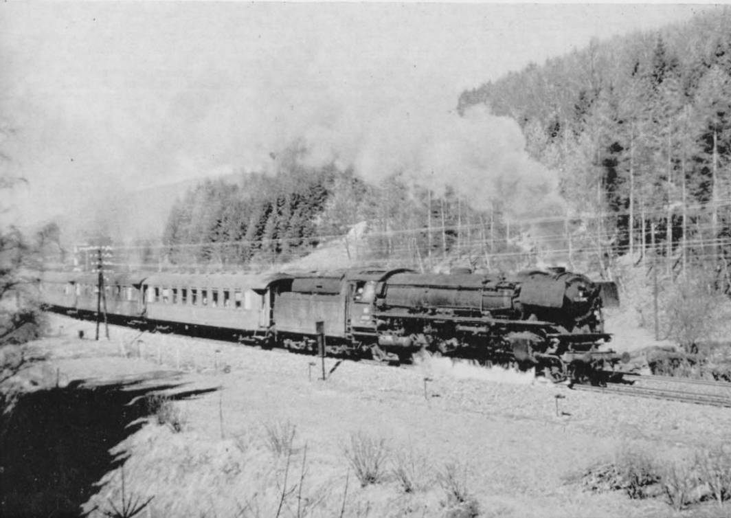
Abb. 21. Auch dieser von einer 03 10 gezogene Eilzug (aufgenommen 1965) setzt sich aus Vorkriegs-Wagen zusammen. Der direkt hinter der Lok laufende Wagen hat noch – vgl. Abb. 4 – die Lüftungsklappen in den Abteilfenstern. (Foto: Dr. R. Brüning, Bruchköbel)
