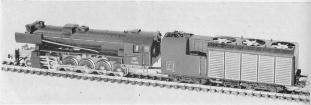
Abb. 2. So sieht die zweite, gänzlich vorbildgetreue Version der Kondens-Lok aus: Als Lok fungiert eine „richtige“ 52 von Kleinbahn (die wir seinerzeit in Heft 15/67 besprochen). Bei beiden Loks (vgl. Abb. 1) deutlich zu sehen: die Imitation der Hauptabdampf-Leitung zum Kondens-Tender (zwischen Umlauf und Kessel).
