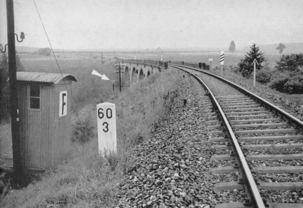
Abb. 10. Bei kleineren Talsenken werden die Freileitungen zumeist nicht auf der Brücke weitergeführt, sondern durchs Tal verlegt. Der Pfeil deutet auf einen etwa am tiefsten Punkt der Senke stehenden Stützpunkt.
