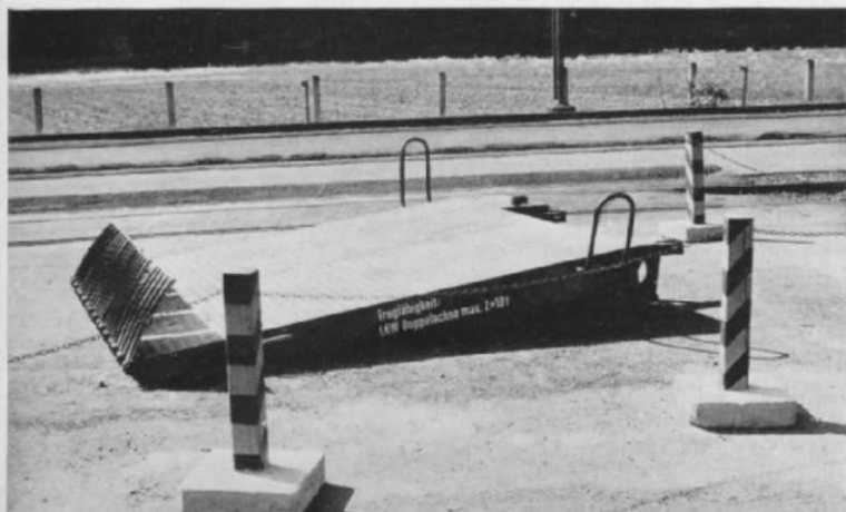
Abb. 4. Ein weiteres für eine Huckepack-Umschlagstelle charakteristisches Requisit: eine auf Rollen bewegliche Auffahr-Rampe, hier vor dem eingebetteten Gleis der Verladestelle in Schönwies.
