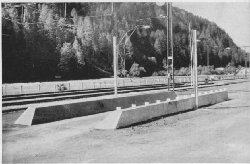
Abb. 3. Diese Profilprüf- und Längenmeßstrecke im Bahnhof Schönwies müssen die Lkw's vor der Beladung passieren — auch dieses sollte im Kleinen nachgebildet werden!
