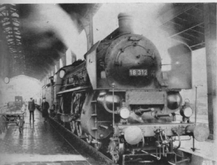
Abb. 9. Diese zeitgenössische Aufnahme – zwischen 1928 und 1934 fotografiert – zeigt die IVh als 18312 der DB (2. Variante, s. Haupttext) vor dem „Rheingold“ in Mannheim Hbf. Neu hinzugekommen gegenüber der Ursprungsausführung (vgl. Abb. 8) sind die kleinen dreieckigen Windleitbleche mit der typischen Abknickung (vgl. Zeichnung Abbildung 5). Als interessanter Größenvergleich zu den übermannshohen Treib- und Kuppelrädern mag der neben dem Führerhaus stehende Beamte dienen!
