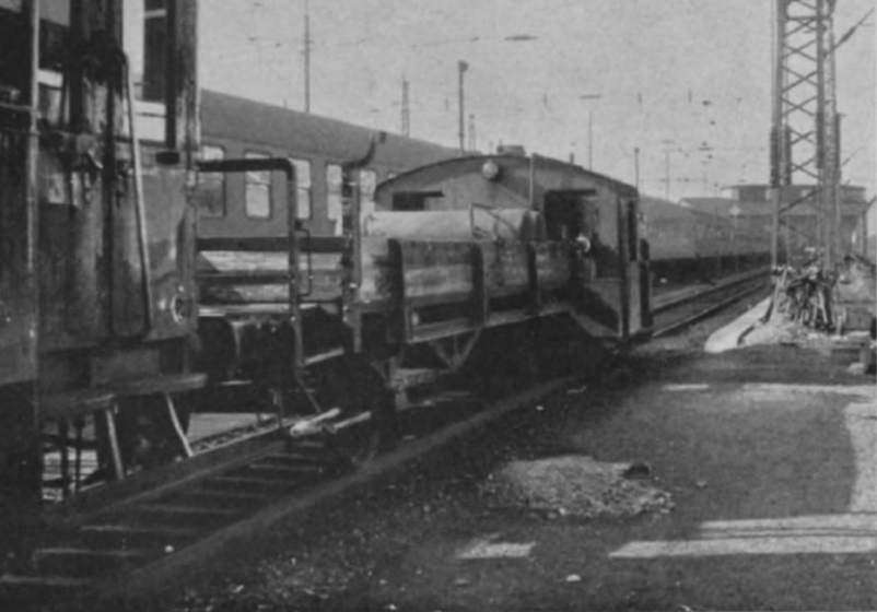
Abb. 1. Der DB- „Geisterwagen“ mit den zusätz- lichen Druckluft- behältern für die Köf, aufgenommen im Bremer Hbf. Fotos: H.-J. Buhl, Bremen
