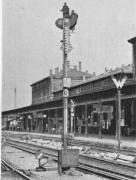
Zwei bayerische Ruhe-Halt-Signale in der typischen Ru-Stellung, aufgenommen im Hbf. Hof. Das hintere Signal steht infolge Platzmangels auf dem Bahnsteig. (Foto: K.-E. Maedel, Nieder-Roden)
