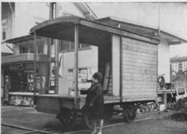
Abb. 1 u. 2. Dieser alte, als Güterschuppen hergerichtete G-Wagen steht im Bahnhof Herisau-Wilen der Appenzeller Bahn. Die Vorderseite (zur Laderampe weisend) ist offen und mit einer Dachrinne versehen, während die Rückseite mit einer großen Schiebetür ausgestattet ist (auf dem Bild links halb geöffnet).
