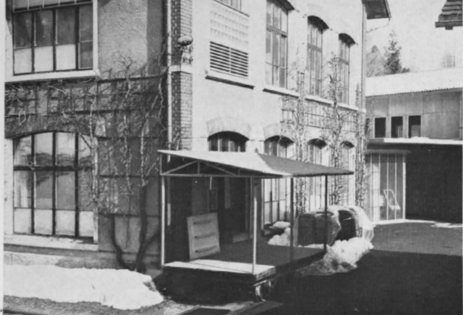
Abb. 3. Diese völlig offene, fahrbare Laderampe ist die Eigenkonstruktion einer privaten Firma und in deren Werk am Haltepunkt (mit Anschlußgleis) Zürchersmühle eingesetzt.
