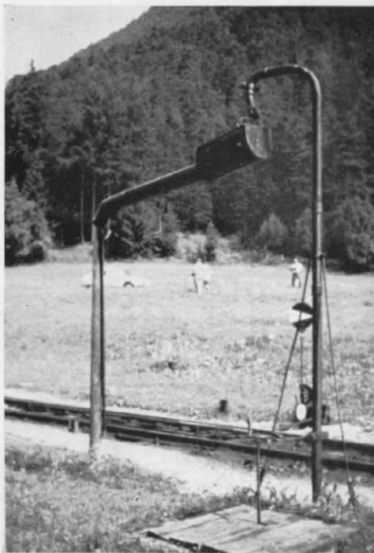
Abb. 4. Dieser Schmalspur-Wasserkran mit schmalen Standrohr und langem Ausleger steht im Bahnhof Jenbach der Zillertalbahn. (Foto: Erwin Trimmel, Lindenberg) — Abb. 5. Bei der Achensee-Bahn ist dieser nicht minder „schmalspurige“ Wasserkran, ebenfalls mit einer Art „Auslegerwanne“, zu Hause. (Foto: Franz Froschmeier, München)
