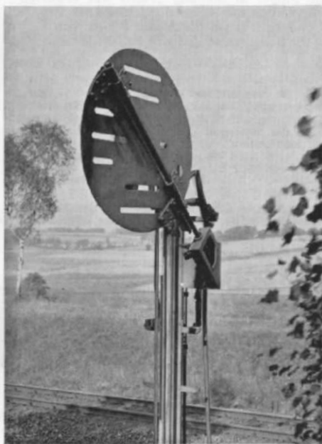
Abb. 12–15. Nahaufnahme des fertig zusammengesetzten Antriebsmechanismus beim Modell-Vorsignal (oben) im Vergleich zu zwei entsprechenden Vorbild-Aufnahmen von E. Köditz, Kulmbach (unten) – und zwar jeweils in Frei- und Warnstellung. Die Bezeichnung der Einzelteile auf Abb. 12 entspricht Abb. 7, 8 und 18. Maßstab der Modellfotos ca. 2-fach H0.
