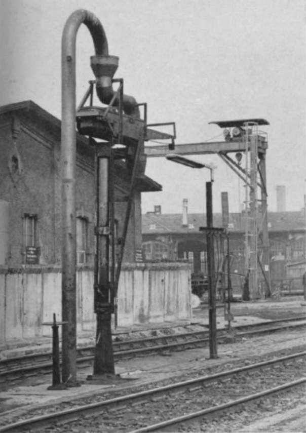
Abb. 6 u. 7. Ein hochinteressantes Stück (und eine Delikatesse für einen Bastler): Wasserkran mit verschiebbarer Ausleger-Wanne im Bf. Kempten. Diese Wasserkran-Konstruktion ähnelt im Prinzip einem Kran mit Gelenkausleger (s. Abb. 8–10), nur läuft hier das Wasser in eine Wanne, die auf Gleitrollen mittels Kettenzügen auf dem vom Standrohr getrennt gelagerten und drehbaren Stützgestell bewegt und so dem jeweiligen Abstand des Lok-Wasserkastens angepaßt wird. (Foto: U. Czerny, Rottenburg)
