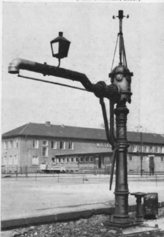
Abb. 2. Dieser verschnörkelte Oldtimer-Wasserkan, der vermutlich noch aus der Zeit um 1860 stammt, kann als Nachbauvorlage für denjenigen dienen, dem die Regelbauarten zu „sachlich“ sind.
