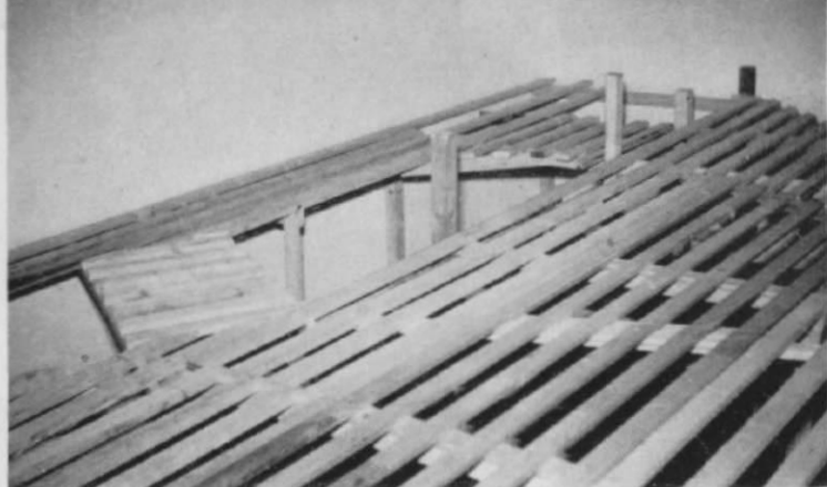
Abb. 4. Anschließend wird das Rahmengestell mit dem Lattenrost verstärkt, der gleichzeitig die Auflage für die zweifache Dämmplatten-Schicht (s. Abb. 5 u. 6) bildet.
