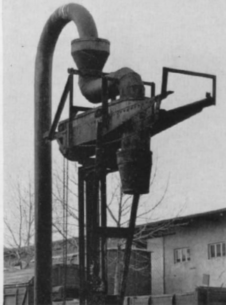
Abb. 6 u. 7. Ein hochinteressantes Stück (und eine Delikatesse für einen Bastler): Wasserkran mit verschiebbarer Ausleger-Wanne im Bf. Kempten. Diese Wasserkran-Konstruktion ähnelt im Prinzip einem Kran mit Gelenkausleger (s. Abb. 8–10), nur läuft hier das Wasser in eine Wanne, die auf Gleitrollen mittels Kettenzügen auf dem vom Standrohr getrennt gelagerten und drehbaren Stützgestell bewegt und so dem jeweiligen Abstand des Lok-Wasserkastens angepaßt wird. (Foto: U. Czerny, Rottenburg)
