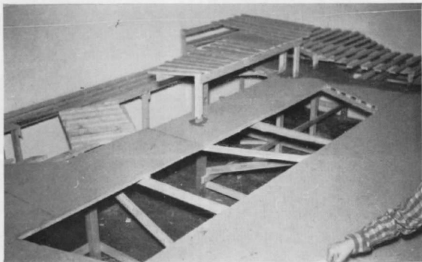
▼ Abb. 5. Für notwendige Eingriffe in die Anlage werden Ausschnitte in Lattenrost und Dämmplatten-Schicht belassen;
