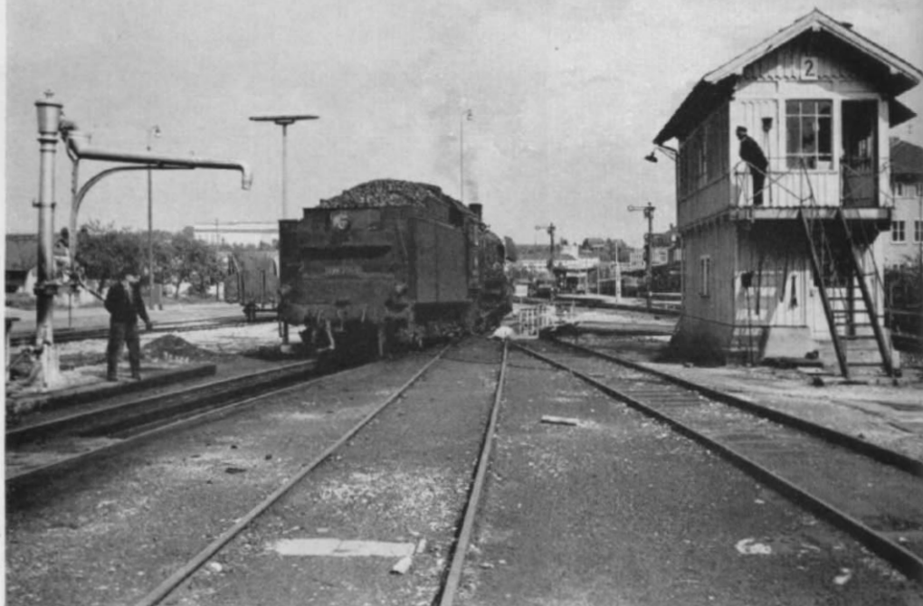
Abb. 11. Ein „Preuße“ von zwei „Schwaben“ flankiert: eine preußische P 8 zwischen einem offensichtlich renovierten Wasserkran in alt-württembergischer Bauart und einem ebenfalls „oldtimigen“ Stellwerk (ähnlich dem Kibri-Stellwerk „Marbach“ oder dem Vollmer-Modell „Moosbach“). Die Aufnahme (U. Czerny, Rottenburg) entstand im Bw Sigmaringen und strahlt irgendwie eine idyllische Gemütlichkeit aus.
