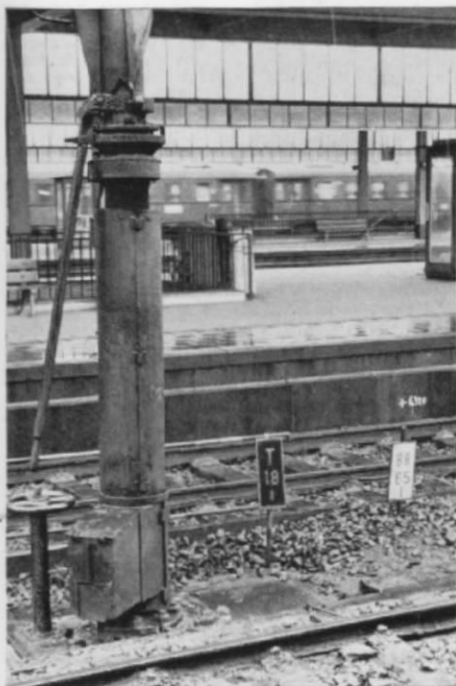
Abb. 13. Bei diesem Wasserkran im Essener Hbf. sind neben dem Beheizter vor allem die kleinen Schilder „T 18“ und „BR 65“ interessant, die z. Z. des Dampfbetriebs den Lokführern dieser Baureihen als Markierung zum „punktgenauen“ Bremsen vor dem Kran dienten. (Foto: M. Schroeder, Essen)
