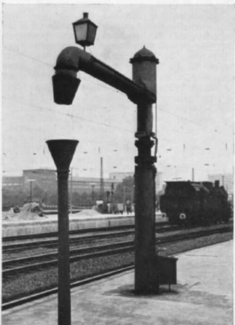
Abb. 5. Auch auf Bahnsteigen findet (bzw. fand) man häufig Wasserkräne — hier ein NW 200 —, die bei Zwischenhalten die Vorräte der Schnellzugloks ergänzen.
