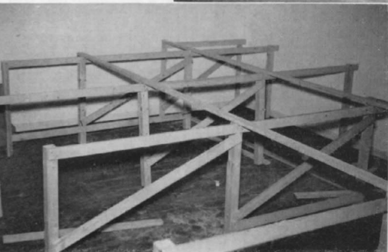
Abb. 3. Nach dem Aufstellen der Rahmen im 1 x 1 m-Netz werden diese provisorisch mit darübergehefteten Latten versteift. Die diagonalen Verstrebungen ergeben zusätzliche Stabilität.
