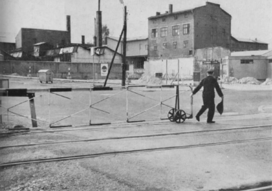
Abb. 1. Mit einer roten Fahne „bewaffnet“ zieht der Beamte gerade das Metallgitter über die Straße. Unter seiner linken Hand befindet sich der Haken, mit dem die „Rollschränke“ am Anschlag gesichert wird.
