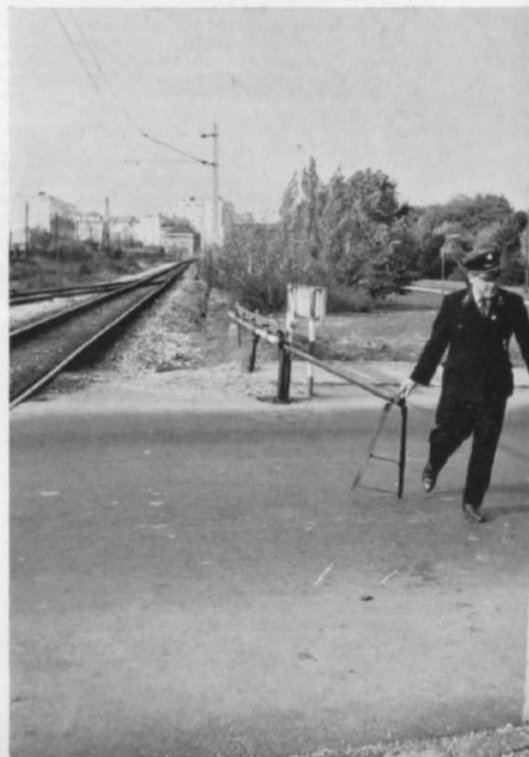
Abb. 2. Auch die andere Straßenseite wird im Eilschritt mit der Eisenrohr-Ziehschränke gesichert.
