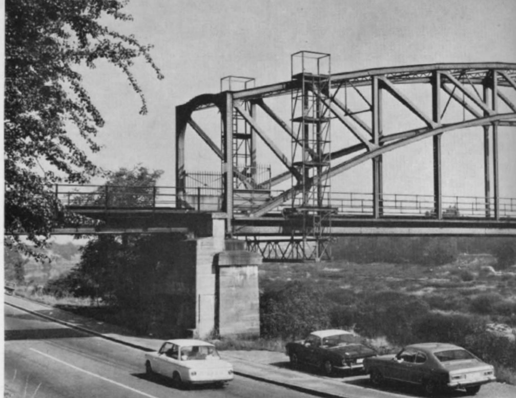
Abb. 11 u. 12. Fast ein Anlagen-Thema für sich! Dies ist die bahneigene Brücke über den alten Neckar und den Neckar-Kanal (im Hintergrund). Am diesseitigen Ufer befindet sich kurioserweise ein Tor, wohl um Unbefugte am Überqueren zu hindern. Eine weitere Anregung für den Brückenbauer sind die Laufkatzen zum Zwecke der Inspektion und Wartung und für Reparaturarbeiten, wie sie in ähnlicher Form an allen Stahlbrücken anzutreffen sind, die über ein Gewässer führen. Ursprünglich bestand die Brücke aus drei Bogen, den mittleren hat man seinerzeit „5 vor 12“ gesprengt. — Diese Panorama-Aufnahme kam dadurch zustande, daß wir 2 Bilder des Verfassers entsprechend aneinander paßten.
