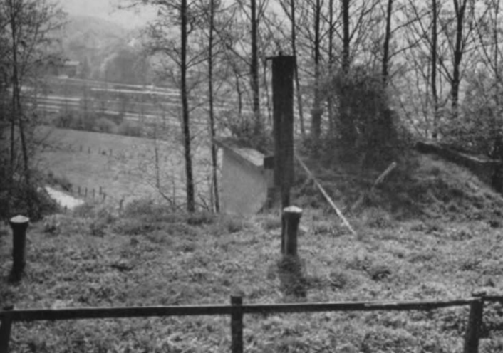
Abb. 21 u. 22. Auch dieser Hochbehälter ohne Unterbau liegt in Altenbeken; er dient zur Versorgung des dortigen Bw's mit Betriebswasser. Rechts neben dem Eingang (Bild unten) erkennt man den (auf „voll“ stehenden) Wasserstandsanzeiger, der auch vom Bw einzusehen ist. Diese Aufnahme ist eine informative und lehrreiche Anregung für die Gestaltung eines Hanges in Bahnhofs- oder Bw-Nähe!
