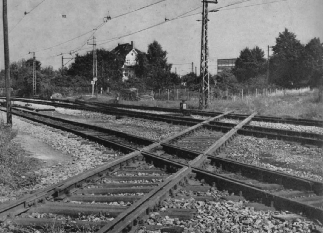
Abb. 1. Die Schmalspur-/Normalspurkreuzung „hoch drei“ im OEG-Bahnhof Heidelberg (vgl. deren Lage im Gleisplan Abb. 4). Ein gewisses Problem stellt beim Nachbau die getrennte Stromführung der Schienen dar; im Heft 6/67, S. 300, wurde aufgezeigt, wie diese mit UHU plus an den Berührungsstellen gegeneinander isoliert werden. Wer es sich einfacher machen will, wandle die in MIBA 5/70 vorgestellte H0e/H0-Kreuzung der Fa. Tempo entsprechend ab!
