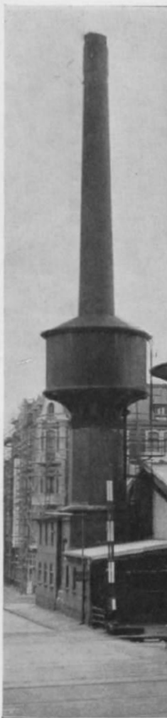
Abb. 8 u. 9. Auch das gibt es: Zwecks Kosten- und Platzersparnis (wie auf der Modellbahn . . .!) war der Wasserbehälter im Bw Wilhelmshaven um einen Schornstein herumgebaut. Ob man einem Modellbahner solch' eine Lösung „abkaufen“ würde? Von einem „Wasserturm“ kann in diesem Falle also weniger gesprochen werden. (Foto: Karl Heinz Buhl, Bremen-Neustadt)
