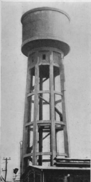
Abb. 8 u. 9. Auch das gibt es: Zwecks Kosten- und Platzersparnis (wie auf der Modellbahn . . .!) war der Wasserbehälter im Bw Wilhelmshaven um einen Schornstein herumgebaut. Ob man einem Modellbahner solch' eine Lösung „abkaufen“ würde? Von einem „Wasserturm“ kann in diesem Falle also weniger gesprochen werden. (Foto: Karl Heinz Buhl, Bremen-Neustadt)
