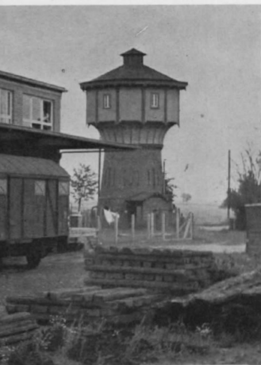
Abb. 12 (rechts unten). Im Bahnhof Belecke steht dieser holzverschaltete Wasserturm; der hochgestellte Schrankenbaum bietet einen Größenvergleich. Man beachte auch den außen angebrachten Wasserstands-Anzeiger! (Foto: J. Zeug, Trier)
