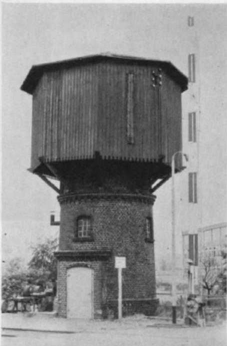
Abb. 12 (rechts unten). Im Bahnhof Belecke steht dieser holzverschaltete Wasserturm; der hochgestellte Schrankenbaum bietet einen Größenvergleich. Man beachte auch den außen angebrachten Wasserstands-Anzeiger! (Foto: J. Zeug, Trier)
