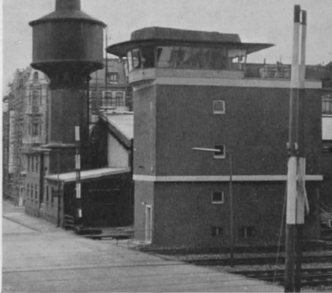
Abb. 8 u. 9. Auch das gibt es: Zwecks Kosten- und Platzersparnis (wie auf der Modellbahn . . .!) war der Wasserbehälter im Bw Wilhelmshaven um einen Schornstein herumgebaut. Ob man einem Modellbahner solch' eine Lösung „abkaufen“ würde? Von einem „Wasserturm“ kann in diesem Falle also weniger gesprochen werden. (Foto: Karl Heinz Buhl, Bremen-Neustadt)
