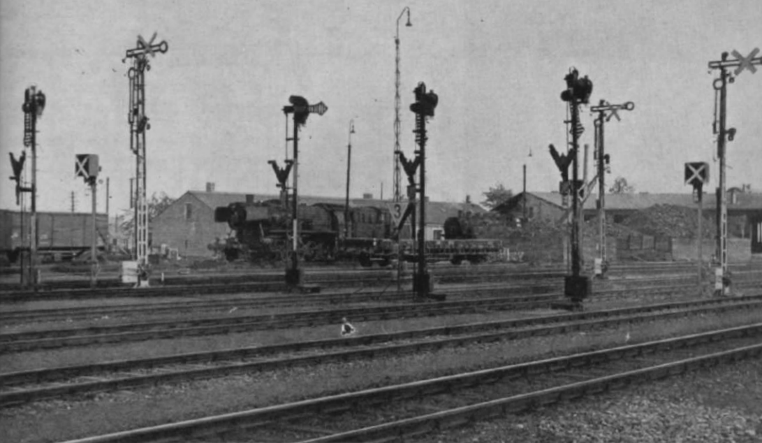
Abb. 3. Ein „Fressen“ für Signal-Fans: bayerische Ruhe-Halt-Signale mit Wart-Signalen am gleichen Mast (eine Besonderheit für sich!) und dahinter deren Ablösung (Formsignale mit Gleissperr-Signalen, mittels Kreuzen noch als außer Betrieb gekennzeichnet), aufgenommen im Mai 1964 in Wiesau/Opf. In nächster Zeit werden übrigens auch die Einheits-Formsignale im Bahnhof Wiesau den modernen Lichtsignalen weichen müssen. (Foto: Hermann Blache, Berlin)
