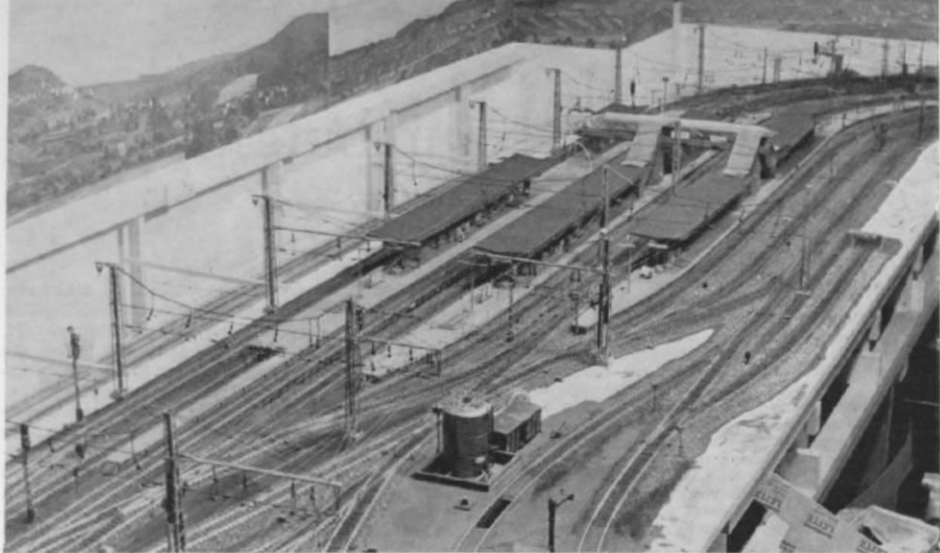
Abb. 3. Blick über „Naumburg Hbf“. Auf der jetzt noch freien Fläche zwischen Bahnsteigen und Wand – über den noch zu erkennenden Gleisen des unterirdischen Abstellbahnhofs – wird das hochgelegene Empfangsgebäude seinen Platz finden. Die Oberleitung stammt von Sommerfeldt und wurde z. T. etwas abgewandelt. Man beachte z. B. die Mast-Sonderformen mit langen Auslegern und seitlicher Speiseleitung. Verlegt wurden im sichtbaren Bereich der Anlage ausschließlich Nemec- und Peco-Weichen bis zu einem Winkel von max. 12°, die mit Repa-Antrieben ausgestattet sind. Im unterirdischen Abstellbahnhof fanden noch vorhandene Fleischmann-Weichen Verwendung.
