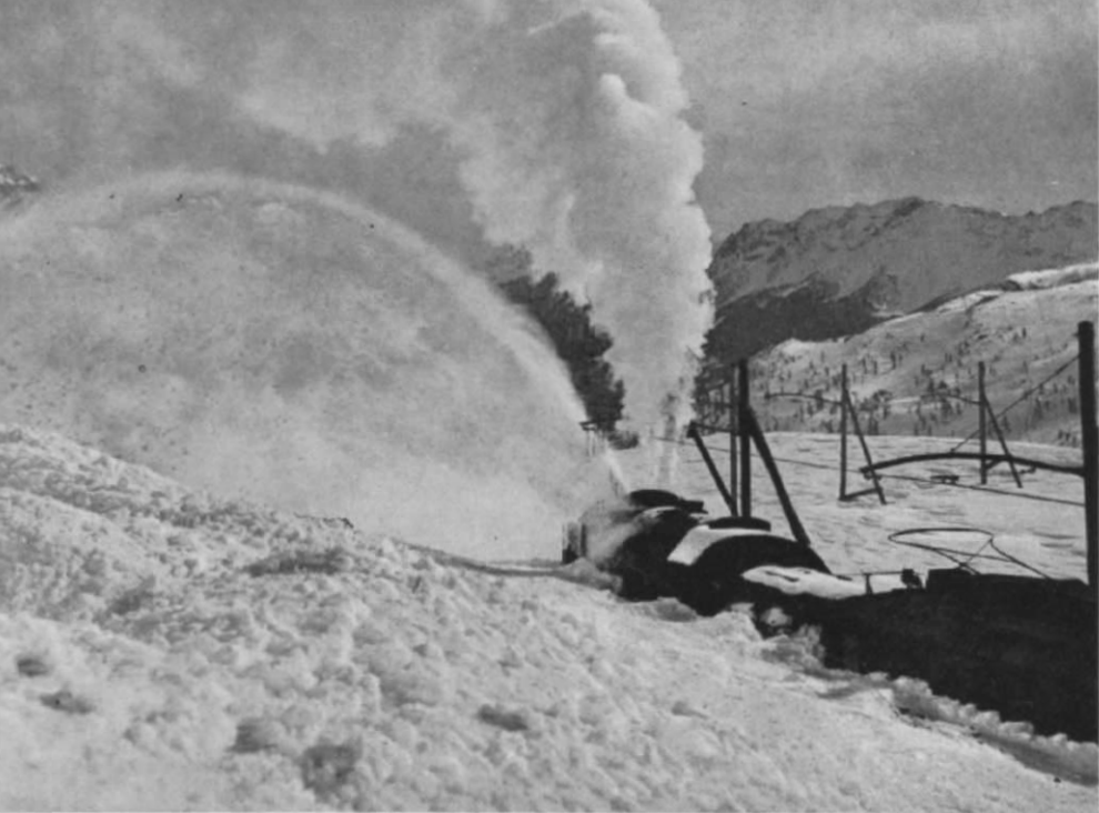
Abb. 1. Eine Dampf-Schneesleuder der Bernina-Bahn im Einsatz. Die Ära der Dampf-Schneesleudern gehört in der Schweiz bereits der Vergangenheit an; sie sind heute alle durch Motor-Schneesleudern ersetzt. (Foto: A. Steiner, St. Moritz/Schweiz)
