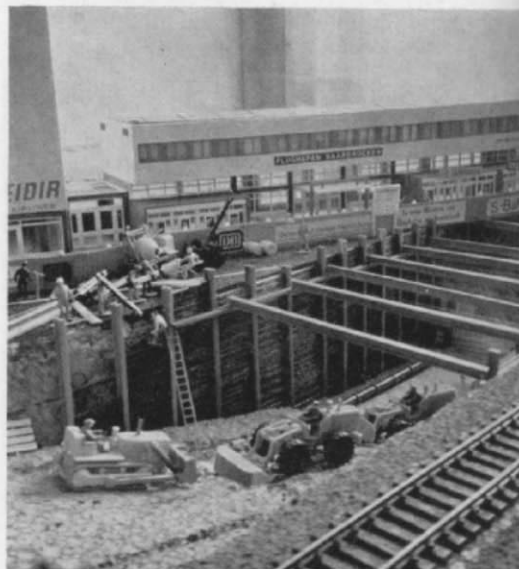
Abb. 10. Die Baugrube ist jetzt in der ganzen Tiefe ausgehoben. Auf der Sohle werden bereits die Drainage-Rohre verlegt. Der Verbau der Baugrubenwände schreitet weiter fort (vgl. Abb. 8). Die „direkte Verbindung vom Flughafen zur Innenstadt“ rückt in greifbare Nähe.
