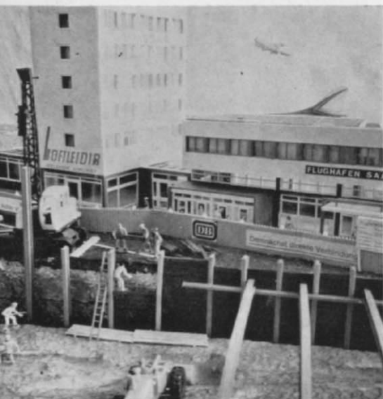
Abb. 9. Hier ist zu sehen, wie zwischen den bereits eingerammten Trägern (links im Bild wird weitergerammt) zur Versteifung Holzbohlen verbaut werden. Über den Köpfen der Arbeiter startet ein Flugzeug – wie dieser verblüffend echt wirkende Effekt erzielt wurde, geht aus dem Haupttext hervor.
