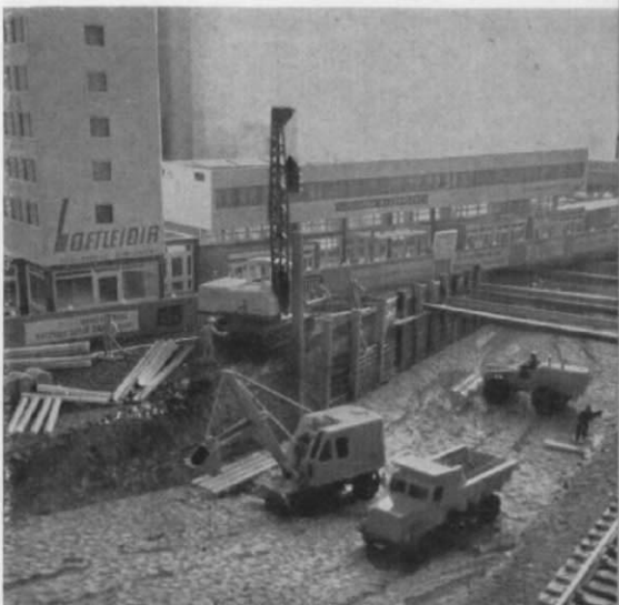
Abb. 8. Die Bauarbeiten machen weitere Fortschritte. Die Baugrube ist jetzt in ihrer ganzen Länge, nachdem die Träger mit Bohlen versteift wurden, in halber Tiefe ausgehoben.
