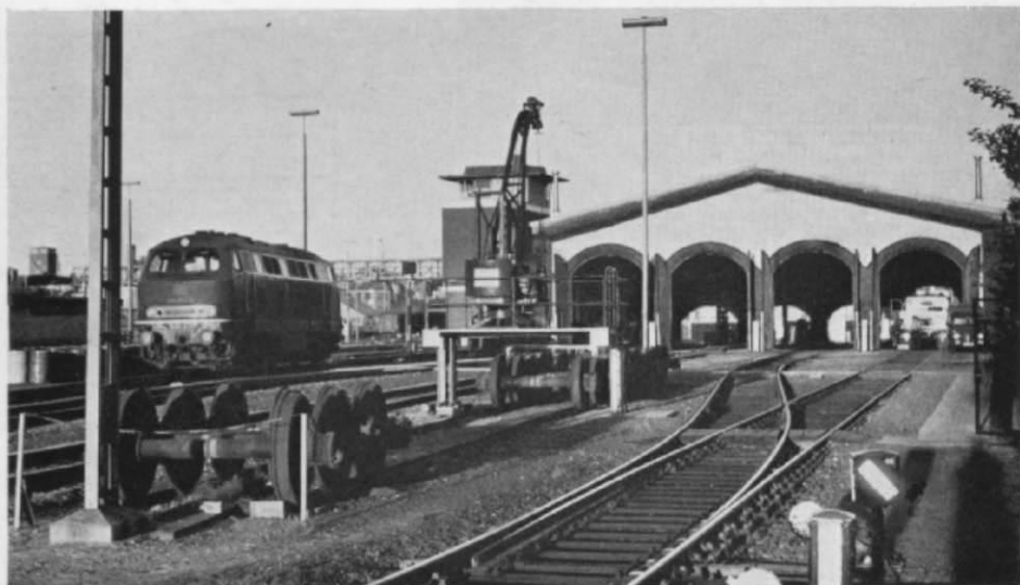
▲ Abb. 2. So sieht die Gesamtanlage mit dem Radsatzkran im Bw Wilhelmshaven aus (vergl. Lageskizze Abb. 3).
