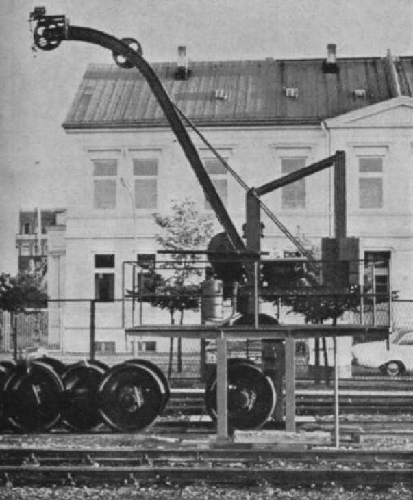
▲ Abb. 8. Die Rückansicht der Verlade- Anlage. Die Gegengewichte des Krans sind auf der außen liegenden Breitseite abge- rundet. Sehr auffällig: die weiß gestrich- ten Warnbleche an den Außenkanten der Tragplattform. Außerdem wird deutlich, weshalb man die Radsätze nicht auf einem normalen Gleis, sondern auf einem breiten U-Profil verrollt (s. a. Abb. 9).
