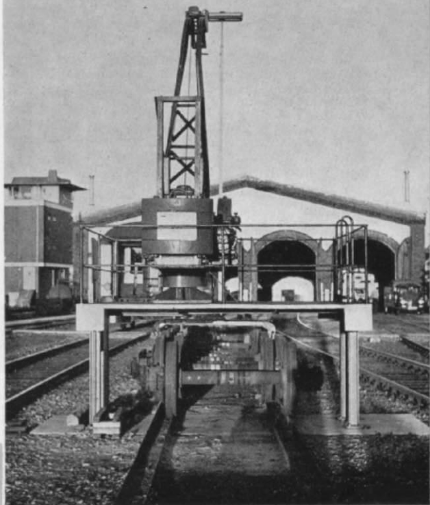
▲ Abb. 8. Die Rückansicht der Verlade- Anlage. Die Gegengewichte des Krans sind auf der außen liegenden Breitseite abge- rundet. Sehr auffällig: die weiß gestrich- ten Warnbleche an den Außenkanten der Tragplattform. Außerdem wird deutlich, weshalb man die Radsätze nicht auf einem normalen Gleis, sondern auf einem breiten U-Profil verrollt (s. a. Abb. 9).
