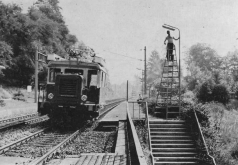
Abb. 1. OBB-Turmtriebwagen X 534.33 mit Einholmstromabnehmer im Hp. Töschling (Strecke Villach — Klagenfurt). Mannschaft und Fahrzeug nebst Bordgerät sind hier zum Lampenstreichen „abkommandiert“!
