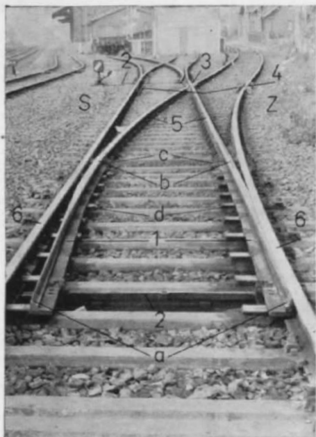
Abb. 1. Einfache Standard-Weiche mit Gelenkzungen-Vorrichtung. S = Stammgleis, Z = Zweiggleis, 1 = Zungenvorrichtung, a = Zungenspitze, b = Zungenwurzel, c = Zungengelenk, d = Gleitstühle, 2 = Stellvorrichtung mit Schieberstange, 3 = einfaches Herzstück, 4 = Radlenker, 5 = Flügelgleisen, 6 = Backenschienen.
