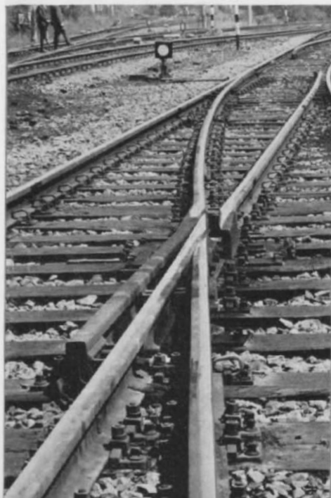
Abb. 7. Einfache Weiche mit beweglicher, geteilter Herzstückspitze der Bauart Friedr. Krupp Hüttenwerke AG. Etwas ungewohnt für unser Auge ist die fehlende zweite Flügelschiene.
