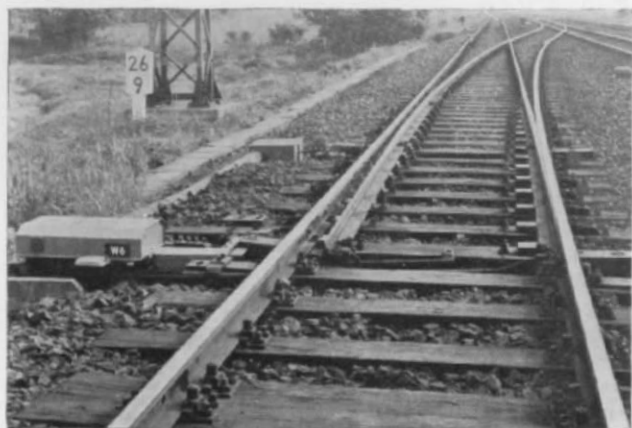
Abb. 1. Einfache Standard-Weiche mit Gelenkzungen-Vorrichtung. S = Stammgleis, Z = Zweiggleis, 1 = Zungenvorrichtung, a = Zungenspitze, b = Zungenwurzel, c = Zungengelenk, d = Gleitstühle, 2 = Stellvorrichtung mit Schieberstange, 3 = einfaches Herzstück, 4 = Radlenker, 5 = Flügelgleisen, 6 = Backenschienen.
