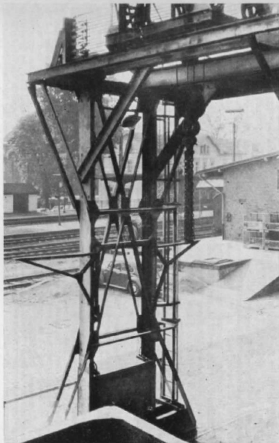
Abb. 8. Detailansicht der Hauptstütze mit beidseitig angebrachten Verstrebungen, dem Kranhaken usw.
