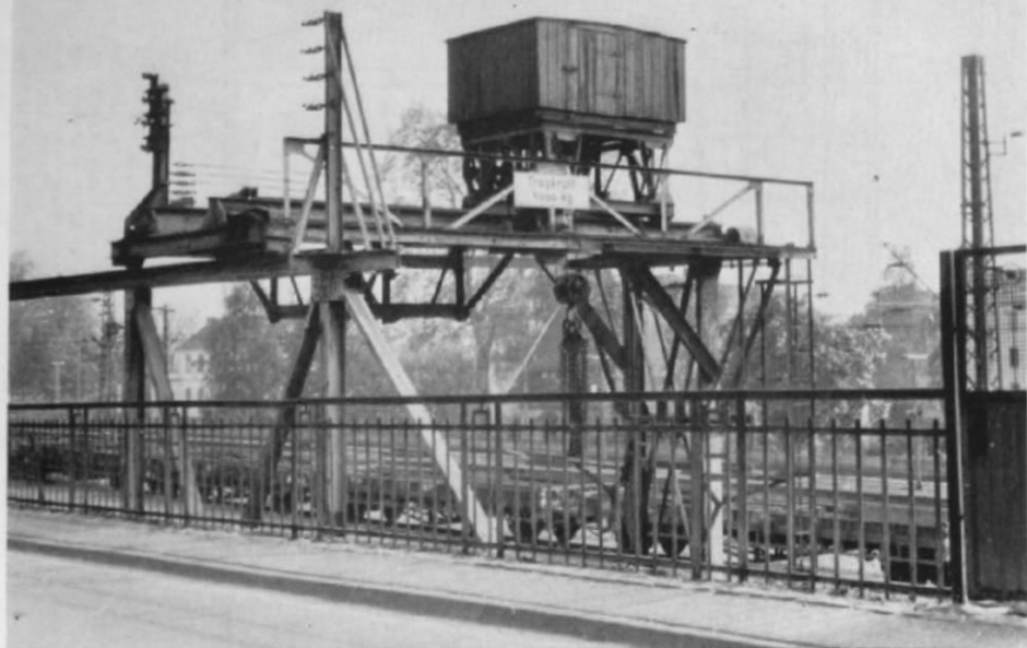
Abb. 6. Die Verladeanlage, von der hochgelegenen Straße aus gesehen. An den vier übereinander aufgehängten Stromkabeln gleitet der Rollen-Stromabnehmer des Krans entlang.
