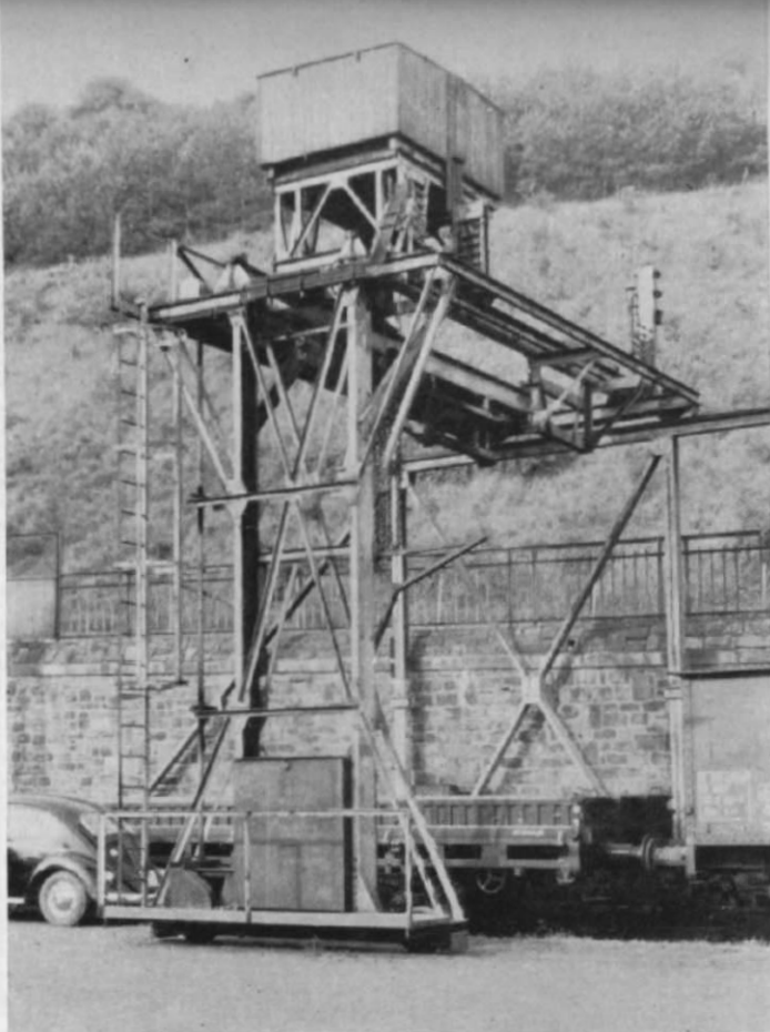
Abb. 9. Eine Totalansicht, die zur Veranschaulichung der diversen Zeichnungen von besonderem Wert ist. Im übrigen beachte man den Schaltkasten zur Bedienung der Laufkatze, sowie den schwarz/gelben Warnanstrich der unteren Streben.
