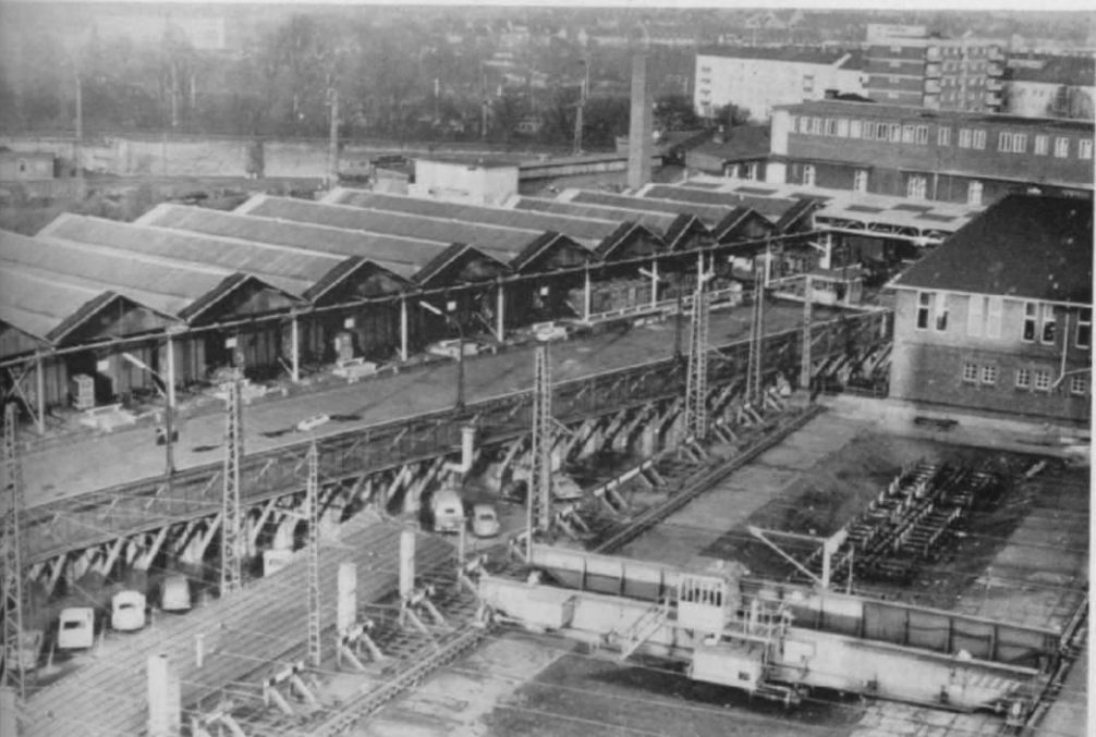
Abb. 7. Hier sind gleich zwei Schiebebühnen von oben zu sehen. Rechts an der Bühne der Abstellgruppe ist der kleine Kran zum Aufnehmen der Radsätze aus der Grube gut zu erkennen. Die linke Schiebebühne gehört zum Bahnpostamt und dient zum Umsetzen der G-Wagen.
