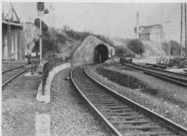
Abb. 19. Tatsächlich eine sehr interessante Unterführung, wie geschaffen für einen Nachbau im Kleinen! Eine weitere Anregung: das gittergeschützte Hauptsignal, das im Verein mit der Indusi-Einrichtung (Kästchen neben dem mittleren Gleis) die Einfahrt in den Güterbahnhof Gereon sichert.
