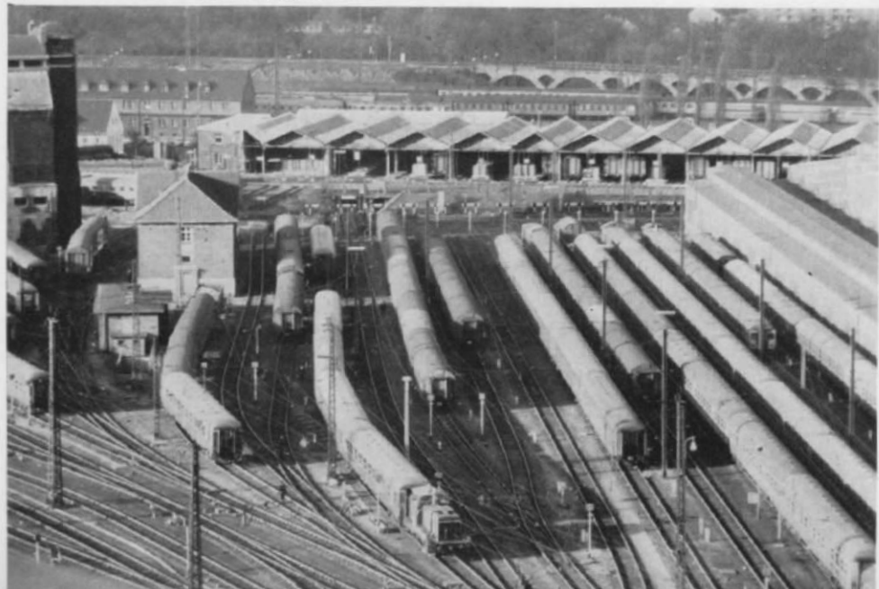
Abb. 4. Die mittlere Abstellgruppe, deren Gleise stumpf an der Schiebebühne enden. Im Hintergrund stehen – parallel zum Viadukt – die mittellangen Reisezüge.
