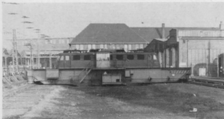
Abb. 11. Wenn El-loks umgesetzt wer-den, müssen beide Bügel eingezogen werden, da die Fahr-leitungen durchge-hend über die Schieberbühne hinweg ver-spannt sind.
