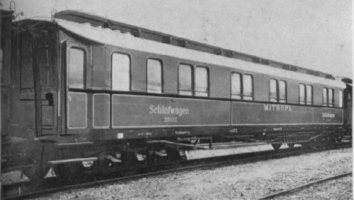
Abb. 2. Erster sechsachsiger Schlafwagentyp der Preußischen Staatsbahn mit Regeldrehgestellen, Baujahr 1905. (Bild: Sammlung K. Gerke)
