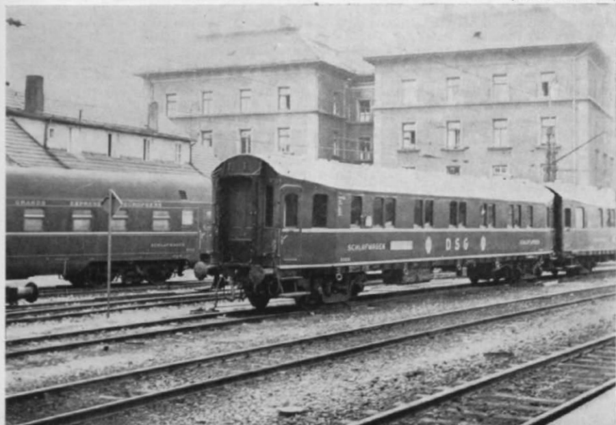
Abb. 4. Ganzstahl-Schlafwagen mit Tonnendach und sich verjüngenden Seitenwänden, erstes Baujahr 1921. (Bild: Dr. F. Stöckl)
