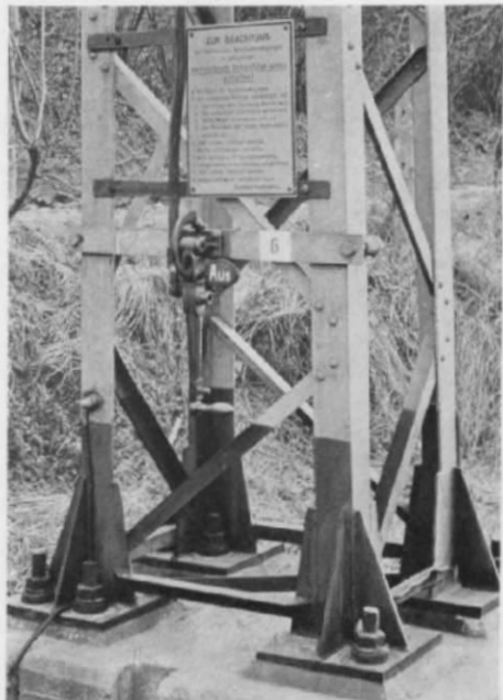
Abb. 16. Hebel eines handgesteuerten Masttrennschalters mit Anweisungstafel.
