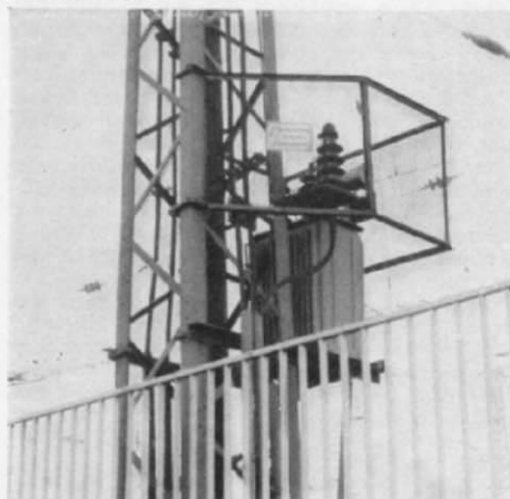
Abb. 19. Masttransformator für Kleinverbraucher 220 V, 16 \frac{2}{3} Hz.
