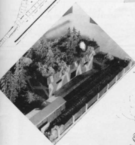
Abb. 4. Der Hügel mit Gleisanschluß – das Munitionsdepot im Innern eines bereits vorhandenen Hügels. Zwischen den Bäumen und Sträuchern sind einige Be- und Entlüftungsrohre anzubringen, deren Äußeres etwas groß geratenen, mit Abdeckplatten versehenen Wohnhausschornsteinen gleicht.
