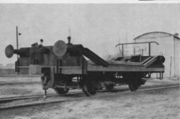
Abb. 1. Zwischenwagen der SWEG (750-mm-Spurstrecke Möckmühl – Dörzbach). Man beachte die Abstützung der Puffer mittels Winkelisen auf den Wagenboden. Die Seitenwände aus Blech sind rotbraun gestrichen, die Stirnwände dagegen schwarz.
