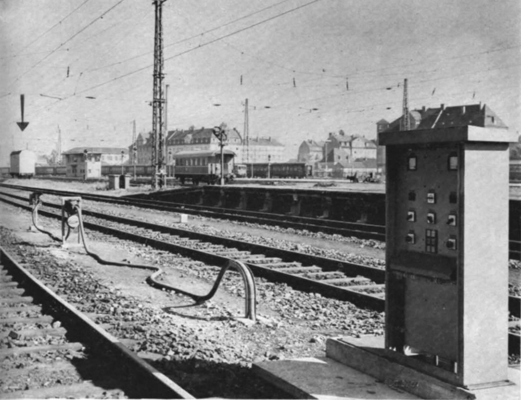
Abb. 11. Ladesäule für die Fernbedienung, einschließlich der Ladekabel mit Steckern, und im Hintergrund (s. Pfeil) die Ladeanlage.
