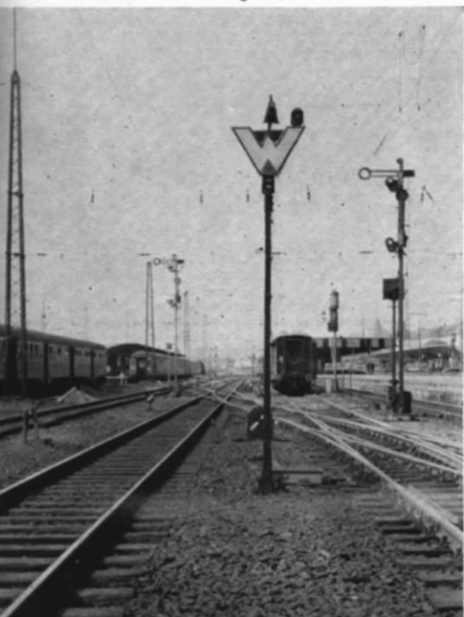
Abb. 2. Das alte Wartezeichen mit Vorrücksignal; letzteres wurde durch Ausschalten der dritten Birne zum „modernen“ Lichtsignal Sh 1. ▶
