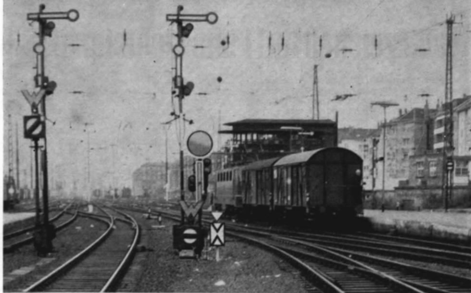
Abb. 3. Wartezeichen bei den Ausfahrtsignalen L3 und L4 sowie als J 3 (ganz rechts) im Mainzer Hbf., ebenfalls fotografiert von Herrn Stumm. Wieso das Wartezeichen links vorschriftsmäßig mit Formsinal Sh 0/1 und Lichtsignal Sh 1, das Wartezeichen in der Bildmitte jedoch ohne Lichtsignal Sh 1 ist, war von hier aus nicht zu eruieren. Gut, das Stellwerk ist in Rufweite, aber das würde für das linke Wartezeichen ebenso gelten. — Das auf dem Kopf stehende kleine Dreieck über der Vorsignaltafel Ne 2 bedeutet übrigens „verkürzter Bremsweg“.
