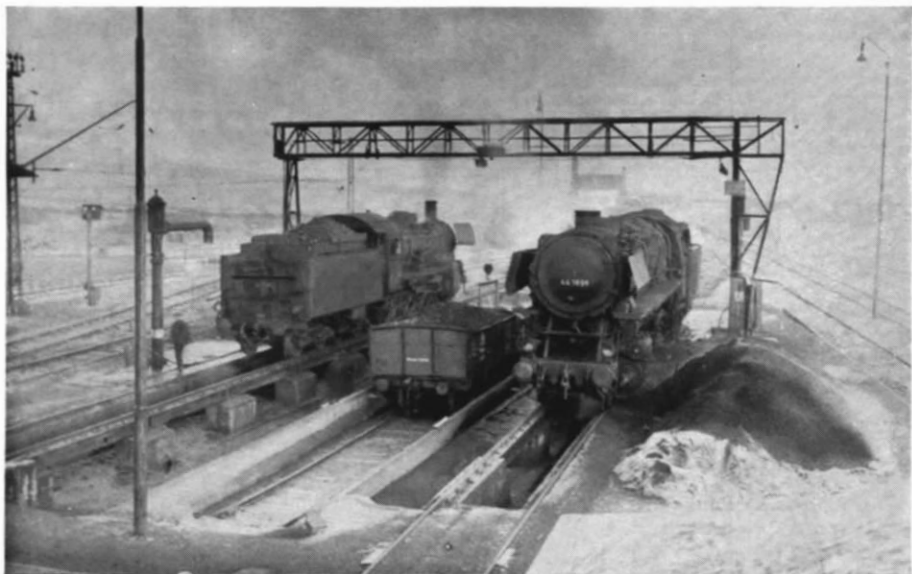
Abb. 5. Eine etwas größere Ausschlackanlage (Treuchtlingen), bei der die Schlacke mittels Bockkran verladen wird. Hier sind die Ausschlackgruben breiter und jeweils ein Gleis ruht auf Betonklötzen, damit die Arbeiter mehr Bewegungsfreiheit haben. Im vorderen Teil der rechten Untersuchungsgrube sind gerade noch die Schienen für die sog. Schlackenhunde zu erkennen, von denen gerade einer am Kran hängt (in Bildmitte, hinter dem Schlackewagen). Das Schürhakenstellwerk befindet sich hier rechts neben dem Kran-Bedienungshäuschen und ebenfalls nicht vergessen werden sollten die Wasserschläuche zum Abspritzen der Schlacke zu beiden Seiten der Anlage. (Foto: Lokbildarchiv Bellingrodt)
