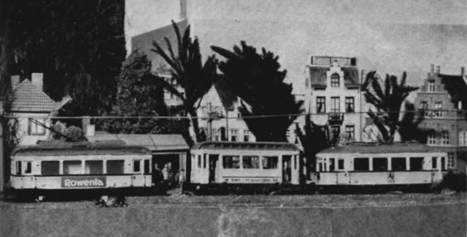
Abb. 2. Endstation der Zweigstrecke im Stadtteil St. Christoph zum Außenbezirk. Das Gleis endet stumpf, ohne Ausweichstelle oder Schleife. Bei Anhängerbetrieb muß daher ein auf dem Zweiggleis abgestellter Triebwagen den Anhänger zur Rückfahrt übernehmen. Im Warthäuschen warten die Fahrgäste das Rangiermanöver ab, um erst danach einzusteigen.
