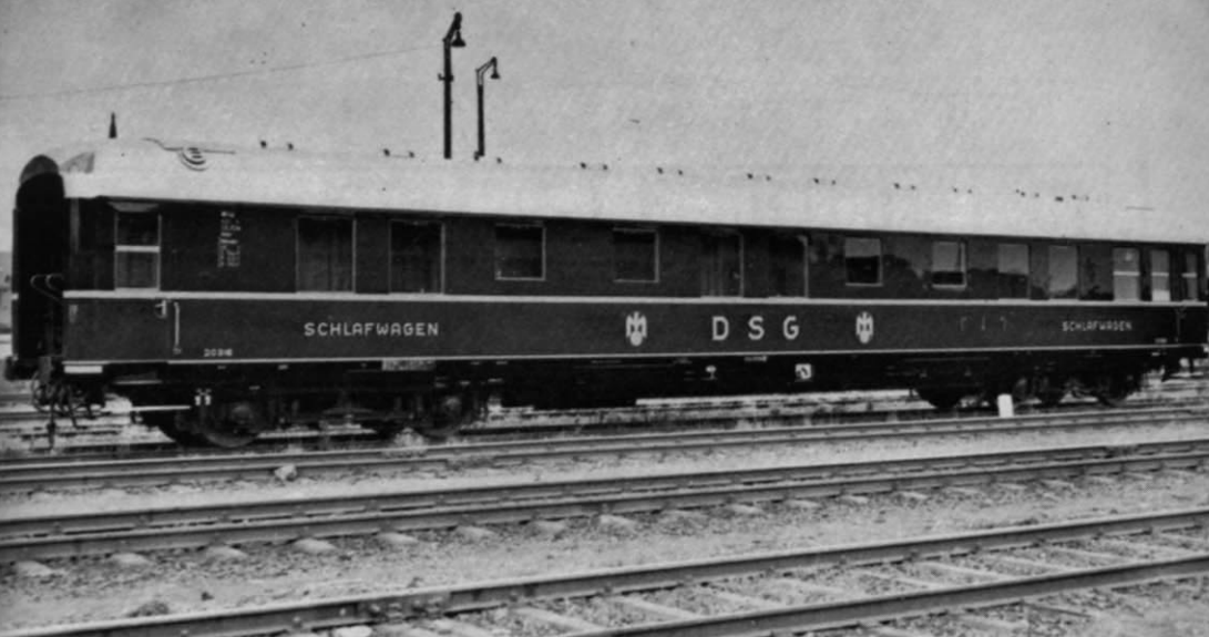
Abb. 1. Schlafwagen der Gattung Wl 4ü, Baujahr 1950, mit Mittelgang und Einbett-Abteilen.
