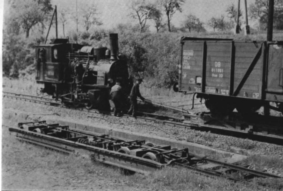
Abb. 1. Rollwagenbetrieb im Bf. Mudau. Im Vordergrund die (zweispurige) Beladungsrampe (das zweite Gleis der Normalspur ist infolge des Grasses nur schwach erkennbar). (Foto: Joh. Schmidt, Nürnberg)
