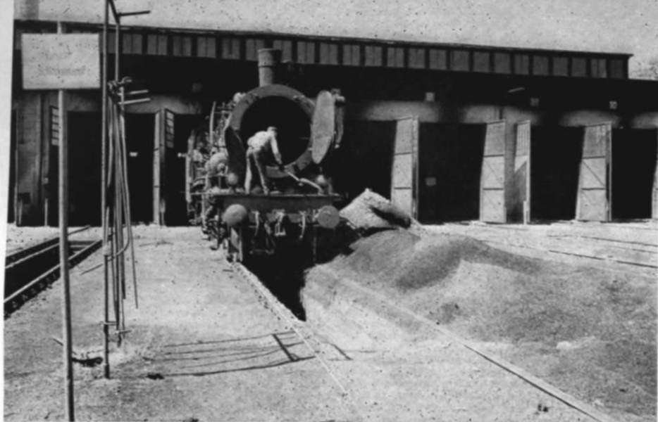
Abb. 1. Hier wird gerade vor dem Lokschuppen des Bw Freudenstadt die Rauchkammer einer Dampflok von der Lösch gereinigt. Für einen Modellbahner ist dagegen weit mehr die Grube von Interesse, nebst Löschehaufen, dem separat stehenden Schürhakenaggestell und dem Schild mit der Aufschrift „Vorsicht Schlackensumpf“.
