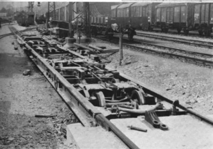
Abb. 3. Drei Rollwagen aneinandergeschoben und derart miteinander verbunden, daß sie gleichzeitig beladen werden können. Die abklappbaren Ösen im Vordergrund halten die RW während des Verladevorgangs an der Rampe fest.
