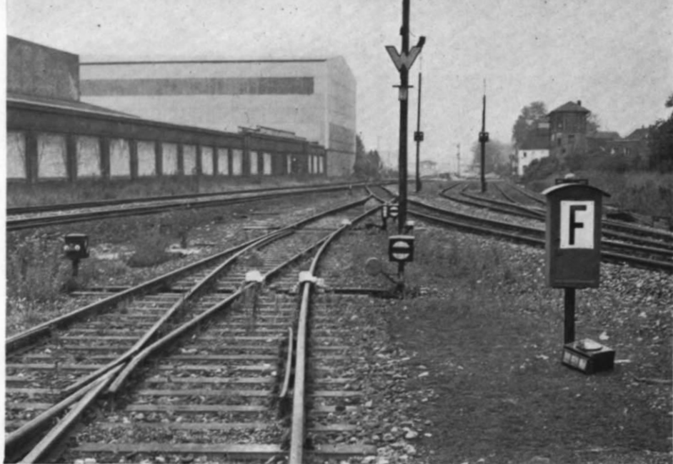
Abb. 1. Der Signalfernsprecher, der als Vorlage für unsere kleine Skizze diente. So „nebenbei“ sind auf diesem Bild aber noch ein paar interessante Dinge zu entdecken: drei Gleissperren (eine vor der Weiche sowie eine doppelte in der Weiche) einschließlich zugehörigen drei Laternen (die vierte Laterne gehört zur Weiche).
