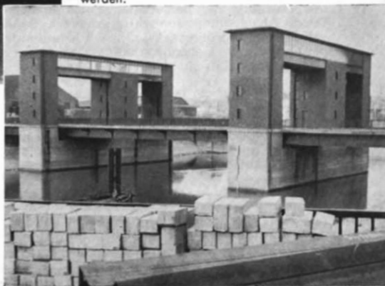
Abb. 19 u. 20. Hubbrücke in gehobener und in Normalstellung. Interessant für die Ausgestaltung: der Pegelmaßstab und die Pontons und Kähne, die zu Ausbesserungsarbeiten in der Kaimauer verwendet werden.
