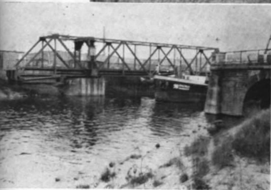
Abb. 21. Eine Drehbrücke (Totalansicht). Auf der rechten Seite ist das Gegengewicht zu erkennen.
