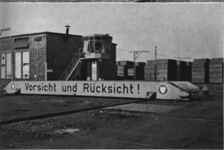
Abb. 15 u. 16. Das Vorbild unseres Bauplans, die Schiebebühne der Maschinenfabrik J. Vögele AG, Mannheim, die zwar für das Verschieben von Waggons gedacht ist, von uns jedoch zu einer Lok-Schiebebühne umgemodelt worden ist. Hier die beiden unterschiedlichen Seitenansichten. Aus Abbildung 15 geht außerdem deutlich der Stromabnehmermast hervor, während auf Abb. 16 die Leitungsmaste ganz gut erkennbar sind. (Werkfotos Vögele, Mannheim)
