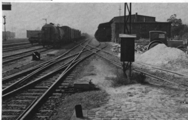
Abb. 4 u. 5. Diese beiden Aufnahmen mögen als weitere Anregungen für die Ausführung und die Aufstellung der kleinen Fernsprecher dienen, die in diesen Beispielen offenbar für den Rangierer vorgesehen sind.
