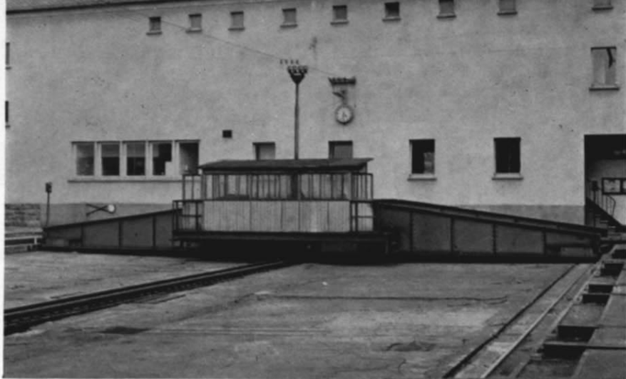
Abb. 10. Die Seitenansicht der Schiebebühne von Trier. Die Stromabnahme erfolgt oben durch Schleifer (für den Modellbetrieb wären hierfür wohl genügend Laufschiene vorhanden). (Foto: J. Zeug, Trier)
