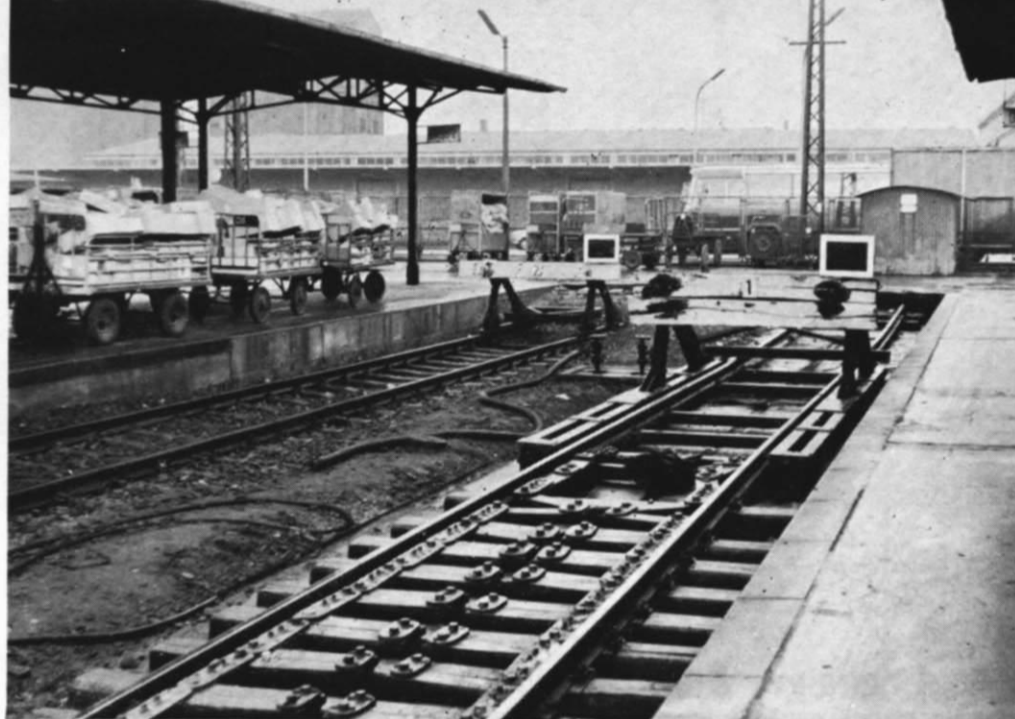
Abb. 25. Bremsprellböcke mit Schleppschwellen — hier offenbar eine ältere Ausführung — gehören in den Kopfbahnhof wie das Salz in die Suppe. (Im übrigen ein Nachtrag zu den „Prellböcken moderner Bauart“ in Heft 8/1937). — Sämtliche Aufnahmen (bis auf Abb. 19 u. 20) von Gübema.
