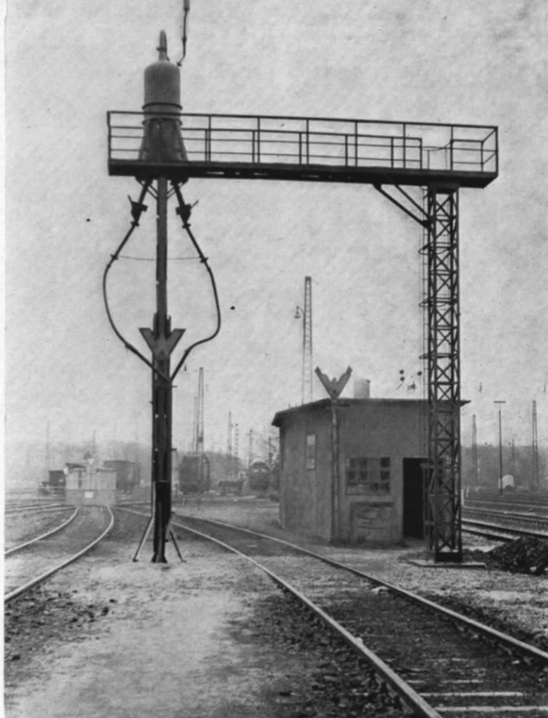
Abb. 1. Die Besandungsanlage in Köln-Eifelort. Auf dem Gerüst ist kein Trockensand-Hochbehälter angebracht, sondern ein sog. Umkehrkasten mit Entlüftungsfilter. Der Druckbehälter dürfte sich im Gebäude befinden. In diesem Fall wird der Sand mit Druckluft (in den Umkehrkasten) gefördert — jedoch nur im Augenblick der Besandung —, dort von der Luft getrennt und rieselt unmittelbar in den Sandbehälter des Fahrzeugs.
