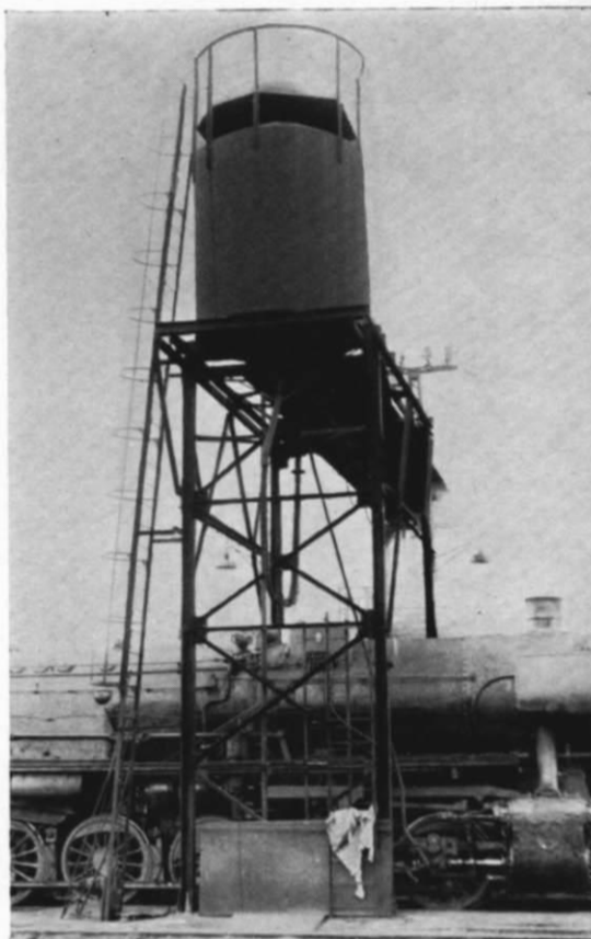
Abb. 12. Der Vorratsbehälter mit dem Fachwerkunterbau; zu Wartungszwecken kann man die Plattform auf dem Behälter besteigen.
