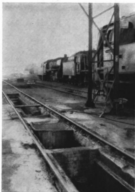
Abb. 13—16. So werden die kleinen Schlackenwägelchen entleert. Mit Hilfe des motorbetriebenen Hubzuges werden sie aus der Grube gehoben und über den bereitstehenden offenen Güterwagen verfahren, wo sie dann von Hand ausgekippt werden.
