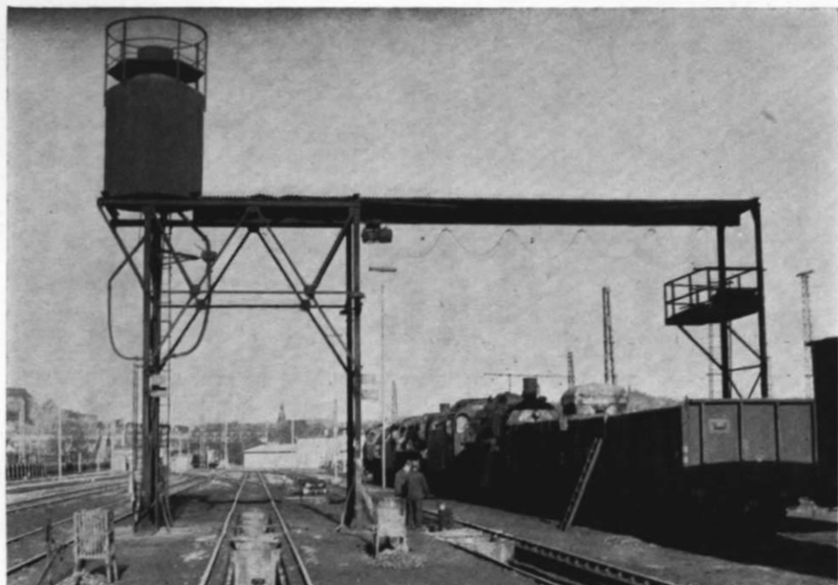
Abb. 1. Die Besandungsanlage mit Schlackenaufzug von der Lokhalle aus gesehen. Ebenfalls gut zu erkennen: Schlacken-, Lösch- und Untersuchungsgrube. Eine Kleinigkeit noch am Rande: die Kohlenbecken, an denen sich das Betriebs- und Wartungspersonal aufwärmen kann (und die im vergangenen Winter bestimmt nützlich waren!).
