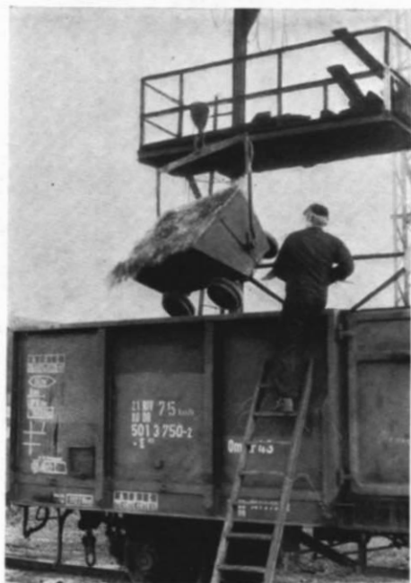
Abb. 13—16. So werden die kleinen Schlackenwägelchen entleert. Mit Hilfe des motorbetriebenen Hubzuges werden sie aus der Grube gehoben und über den bereitstehenden offenen Güterwagen verfahren, wo sie dann von Hand ausgekippt werden.
