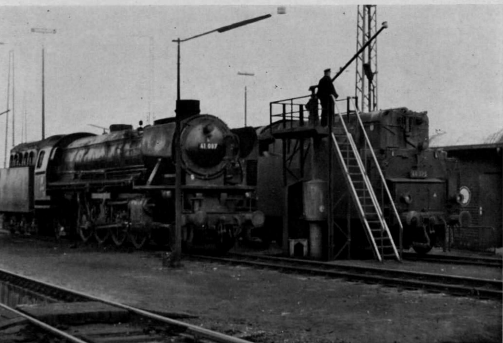
Abb. 1. Der Ölkran mit Bedienungsplattform im Bw Osnabrück als Vorbild unserer heutigen Bauzeichnung. Im übrigen beachte man weitere Anregungen wie z. B. den Bohlenübergang vor der Untersuchungsgrube oder das Schutzgeländer vor der Schuppentür. (Fotos: H. Stemmler, Rottenburg/Neckar)
