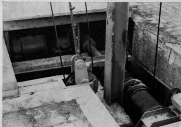
Abb. 4. Details des Fundaments und der Seilführung (Trommelwinden).
