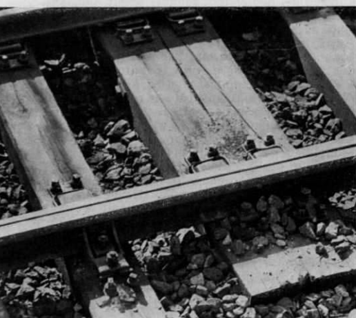
Abb. 3. Die Heizrohre an den Gleitstühlen, die im Kleinen u. E. durchaus vernachlässigt werden können.
