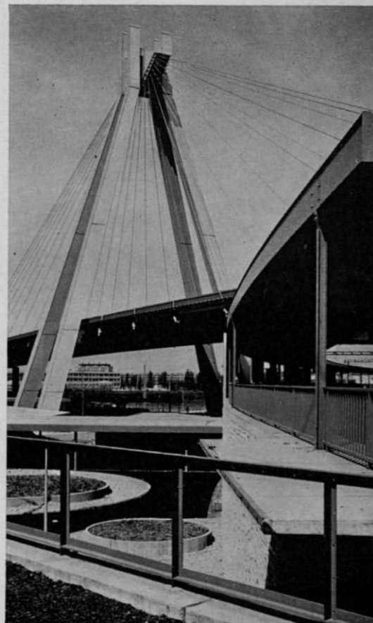
Abb. 1. Das neue Wahrzeichen von Ludwigshafen: der hochaufragende Pylon mit den strahlenförmig zusammenlaufenden 38 armdicken Stahlseilen, an denen die 273 m lange Hochstraße aufgehängt ist.
