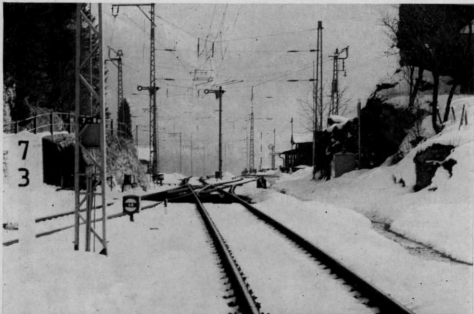
Abb. 1. Blick auf die Gleisanlagen des Bf. Hallthurm, rechts (in Höhe der Dkw) die Weichen-Ölheizung.
