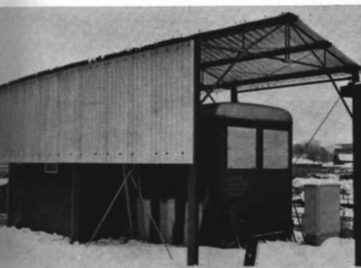
Abb. 3. u. 4. Weitere Aufnahmen vom Stellwerkswagen und von der Schutzabdeckung.
