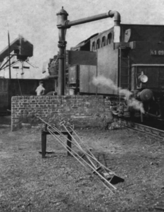
Abb. 6. Wasserkran und diverse Schürhaken (für das Entschlacken).
