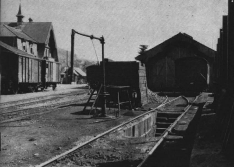
Abb. 11. Eine höchst genügsame „Lokbehandlungsanlage“ (auf gut deutsch eine Bw-Außenstelle), die aber dennoch Bekohlung, Wasserkran, Schlackengrube und Besandung aufweist und für eine Nebenbahn völlig genügt. (Aufgenommen von Herrn Fritz Amsler-Müller, Oberrieden/H., in Tringen/Schweiz).
