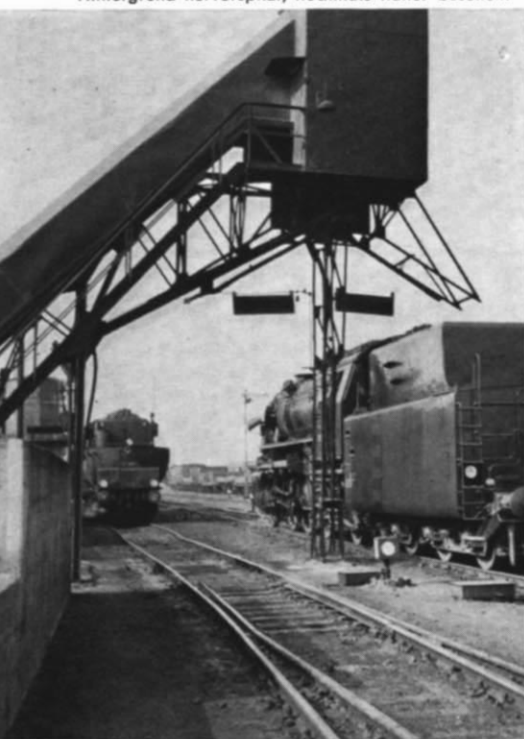
Abb. 7. Die Besandungsanlage, die in Abb. 6 im Hintergrund hervorspitzt, nochmals näher besehen.
