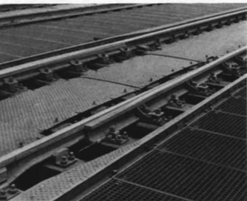
Abb. 1 und 2. Zwei Beispiele für die Blechbeplankung zwischen den Schienen und Gleisen bei offenen Fachwerkbrücken. Zum Teil handelt es sich um Riffelblech, z. T. um moderne Roste.
