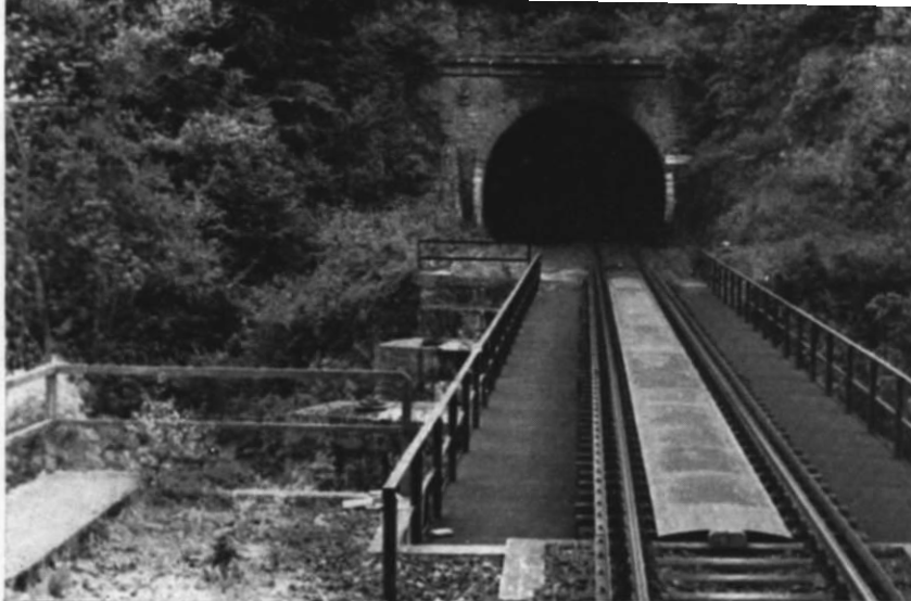
Abb. 1. Eine ehemals zweigleisige Brücke der Eifelbahn (nahe Kyllburg) mit einem Blechbelag wie er sein soll und wie er bei Modellbahnern meist fälschlicherweise nicht üblich ist.
