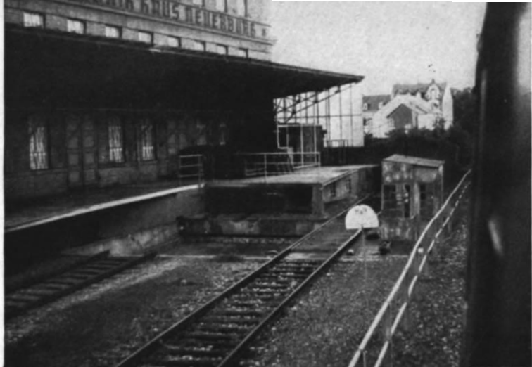
Abb. 1. Die als Weichenersatz dienende Mini-Schiebebühne in Trier-Süd. Loks dürfen nicht auf die Bühne; für sie gilt das Schild „Halt für Rangierfahrten“!
