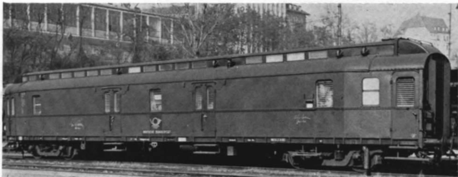
Abb. 8. Auch die Bauart der Postwagen wurde der Schnellzugwagenseerie angepaßt (hier ein Post 4ü, Baujahr ca. 1923). Deutlich zu erkennen die Blechkappen an den Dachenden, während das Dach selbst noch holzverkleidet und mit einer Dachhaut überzogen ist. (Foto: Willke)
