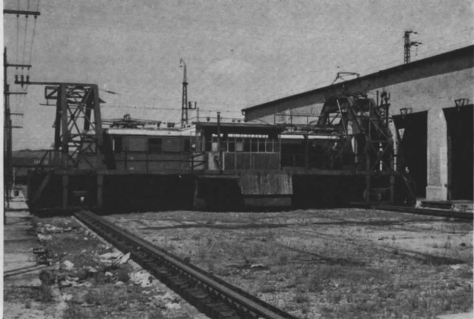
Abb. 2. Schiebebühne des Bw München (mit einer E 18), wie sie vor dem Umbau ausgesehen hat (Aufnahme 1958 vom Verfasser). Gut zu erkennen: der Stromabnehmer auf der Bühne (rechts) für die Fahrstromversorgung der Elloks, sowie die Verriegelungsmechanik (links), deren Konstruktionsprinzip sich der Verfasser in ähnlicher Weise zu-nutze machte.
