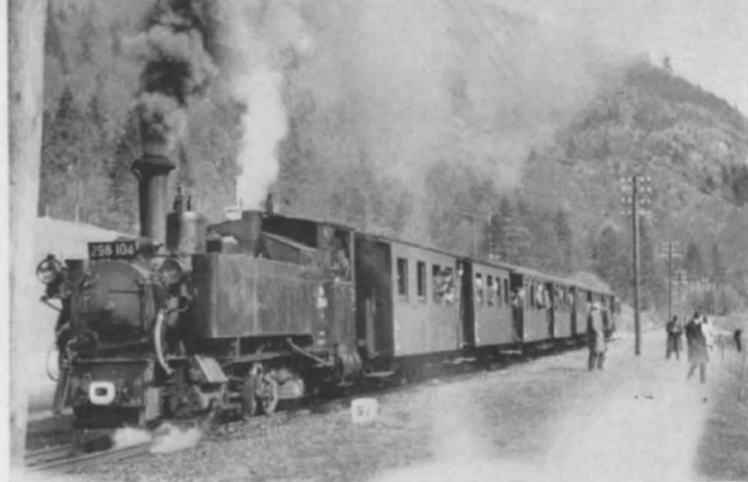
Abb. 11. ÖBB-Lok 298 104 mit Sonderzug auf der Steyrtalbahn (ehem. Nr. 4 dieser Bahn, gebaut von Krauss in Linz im Jahre 1890, bei der DB als 99 7833 registriert) ist ein Vorläufer der Reihe U. Ähnliche Bauarten waren auch von der SKGLB beschafft worden.
