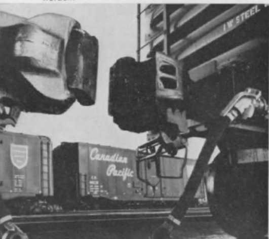
Abb. 9. Eine eindrucksvolle Aufnahme von der amerikanischen Kluvenkupplung, die der bekannten Kadee-H0-Kupplung nachgebildet ist. Hier müssen die Steuerleitungen (im Großen) nach von Hand verbunden werden.
