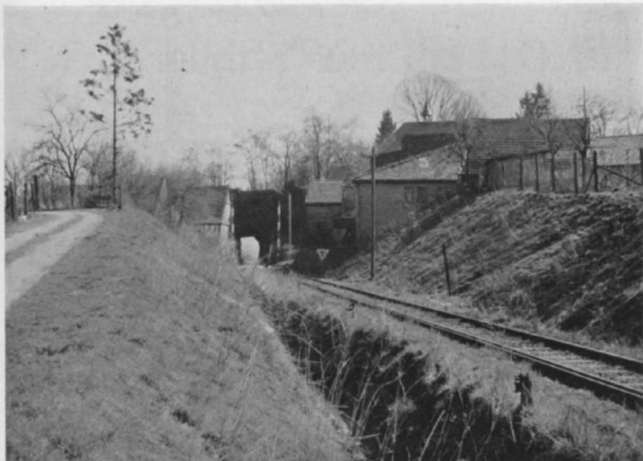
Abb. 3. Und das ist die andere Seite der Geschichte. Interessant ist übrigens auch, daß das Gleis hier teilweise eine Zwangsschiene hat. Das deutet darauf hin, daß sich (in Richtung Reinheim) eine sehr enge Kurve anschließt. Bemerkenswert ist auch die Langsamfahrstelle mit einer Geschwindigkeitsbeschränkung auf nur 10 km/h (!), deren Grund wir aber leider nicht kennen und die doch wohl kaum mit dem arg verdeckten (jedoch schrankengesicherten) Wegübergang zusammenhängen dürfte.
