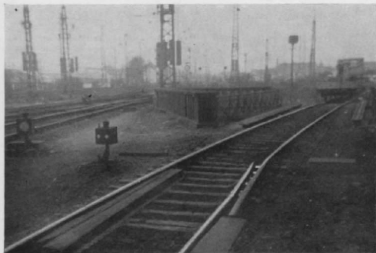
Abb. 1. Zwischen dem Bw und dem Bf. Wilhelmshaven befindet sich eine Abfang-Weiche, die Herr J. Zeug aus Trier mit einem „schweren Tele“ ein- fang (daher die starke Verzerrung).
