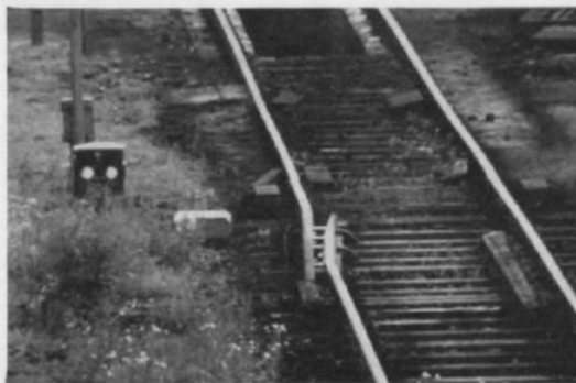
Abb. 1. Zwischen dem Bw und dem Bf. Wilhelmshaven befindet sich eine Abfang-Weiche, die Herr J. Zeug aus Trier mit einem „schweren Tele“ ein- fang (daher die starke Verzerrung).
