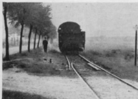
Abb. 6. Reproduktion eines der Bilder aus dem besagten MIBA-Heft 15/1959 mit der „Entgleisungs- weiche“ in Viersen.
