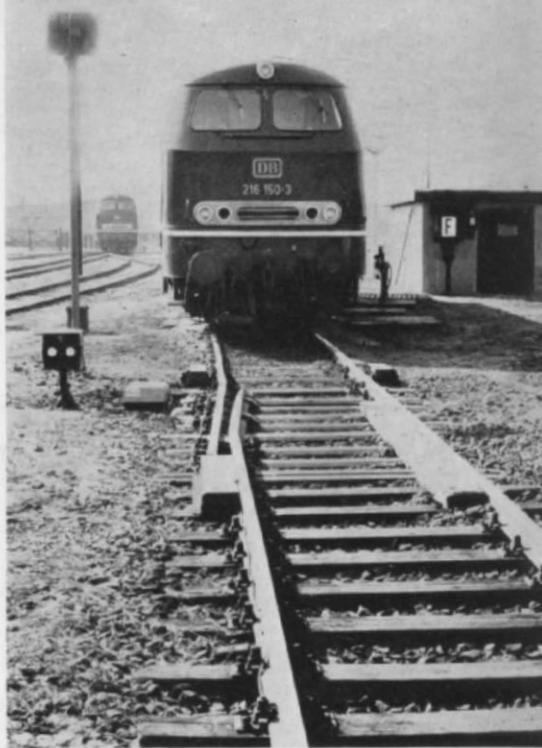
Abb. 3. u. 4. Die Aufnahmen des Herrn Th. Palaschewski aus Wilhelmshaven von der Abfang-Weiche im Bahnhof von Wilhelmshaven; sie ist — im Gegensatz zum Bonner Beispiel — mit einem Gleisspernsignal gesichert.
