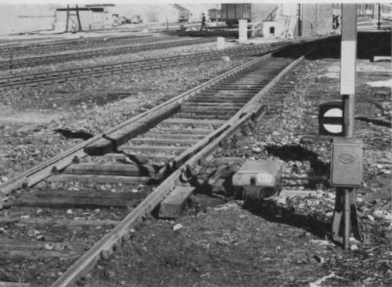
Abb. 3. u. 4. Die Aufnahmen des Herrn Th. Palaschewski aus Wilhelmshaven von der Abfang-Weiche im Bahnhof von Wilhelmshaven; sie ist — im Gegensatz zum Bonner Beispiel — mit einem Gleisspernsignal gesichert.
