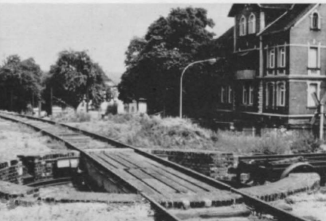
Abb. 2. ... als Rollwagen entpuppt, der eine Breitspur von 1850 mm hat.
