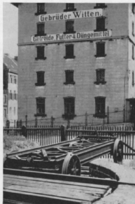
Abb. 2. ... als Rollwagen entpuppt, der eine Breitspur von 1850 mm hat.
