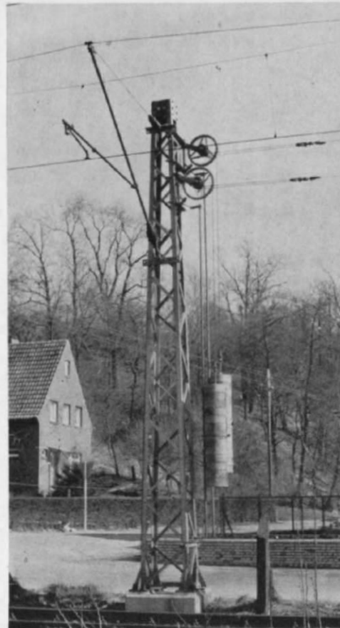
Abb. 9. Spannwerk an einem Turmgittermast. (Foto: DB)
