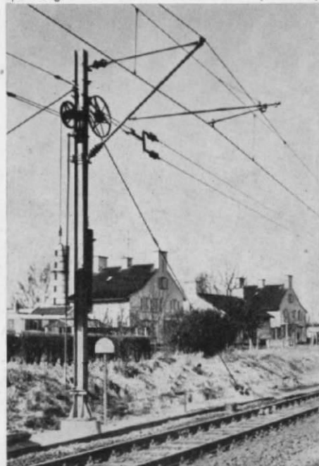
Abb. 8. Breitflanschträgermast mit Spannwerken verschiedener Ausführung und unterschiedlicher Nachspannung. (Foto: DB)
