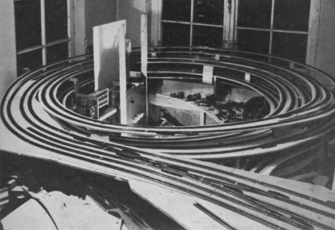
Abb. 1 zeigt die Spirale in der Totalen: der Außendurchmesser beträgt 2,70 m, der Innenraum bietet mit 1,80 Meter immer noch Platz genug für eine kleine Elektrowerkstatt, da sich unter dieser Spirale unsere zentrale Relaisstation befindet. Von rechts her (im Vordergrund) kommen die Gleise unseres Hauptbahnhofes, durch welchen ausschließlich der „Personenverkehr“ geführt wird. Der Güterverkehr liegt eine Ebene tiefer: die Gleisstützen im Vordergrund deuten diesen hier im Bild erst an. Ungefähr in Höhe des Stumpfgleises (oberste Plattform links vorn) wird sich später die Tunneleinfahrt in den „Berg“ befinden.
