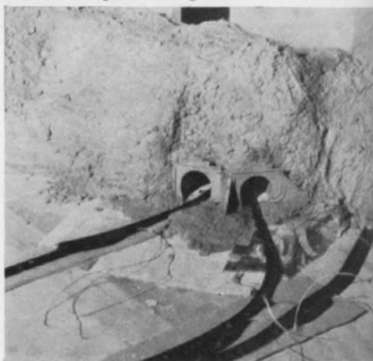
▼ Abb. 12. Der erste „Gelände-Bewurf“ hat die Zeitungslagen überdeckt. Niemand kann jetzt mehr erkennen, wie das Gebirge entstand. Die auf der Platte ohne Geländeerhöhung ruhenden Gleise sind auf 5 mm-Schaumgummi-Matten gebettet.
