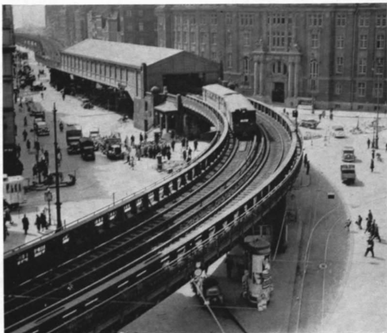
Abb. 5. Und nochmals Hamburg. Hier ist ein Bahnhof und die Hochstrecke der S-Bahn zu sehen (Station Röhdingmarkt). Die Gleise ruhen auch hier wiederum nicht auf einem geschütteten Damm, sondern sie liegen auf einer eisernen Brückenkonstruktion.
