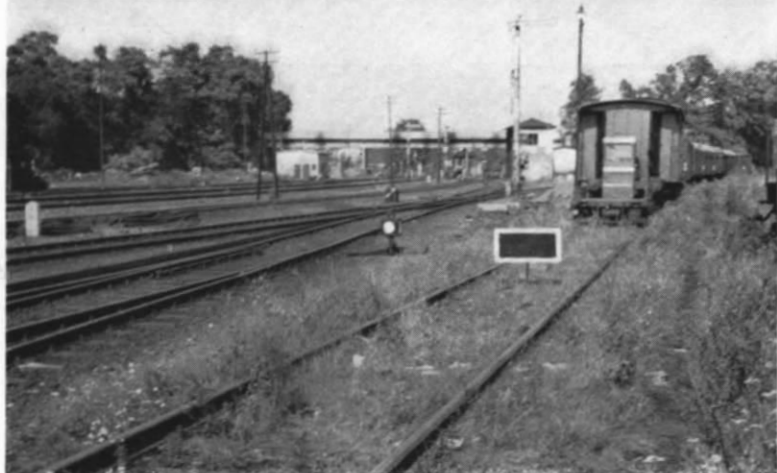
Abb. 1. Schutzhalt-Signal Sh 2 zum Schutz eines abgestellten Bauzuges, der auch im Kleinen solcherart gesichert werden sollte — abgesehen davon, daß die weißumrandete rote Tafel bei einer Farbaufnahme als „roter Farbkleck“ willkommen sein dürfte. (Foto: Ertmer, Paderborn)
