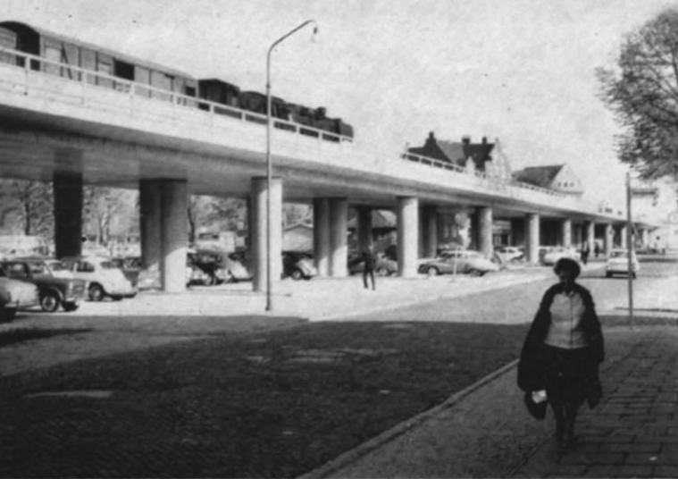
Abb. 1. Das Musterstück einer neuzeitlichen Fahrbahn-Aufständering : die 560 m lange Hochstrecke im Weichbild von Oldenburg. Wenngleich die Stützpfiler doch nicht so modern ausgefallen sind wie in Heft 1/66 gezeigt, so weicht die Konstruktion dieses Bauwerks doch wesentlich von den bisher bekannten Formen und Ausführungen ab und erlaubt überdies eine Doppelbenutzung der im Stadtzentrum so raren Bodenfläche. Abb. 2 (unten). Ein ähnliches Bauwerk im Kleinen mit andersartigen Stützen — ein Motiv aus einer früheren Triang-Ausstellungsanlage.
