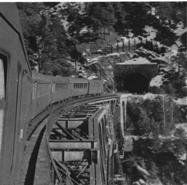
Abb. 1. Blick vom fahrenden Zug aus auf die Bietschtalbrücke. Man kann deutlich den Zweigelenkbogen (Mittelteil) erkennen, ebenso den einen seitlichen Laufsteg (rechts unten). Gut zu sehen ist auch, daß die Tunneln schon von Anfang an so breit gebaut worden sind, daß bei Umstellung auf zweigleisigen Betrieb nur noch das zweite Gleis verlegt werden muß. Eine nette Anregung: der Schutzbau gegen herabfallende Steine über der Tunnel-einfahrt.
