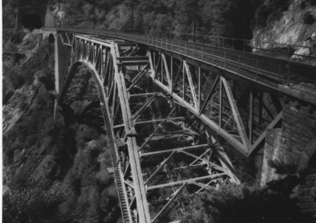
Abb. 8. Aus diesem Bild ist besonders deutlich der Verlauf und die Anordnung der Laufstege und Arbeitsbühnen zu sehen. (Foto: Berner-Alpenbahn-Gesellschaft)
