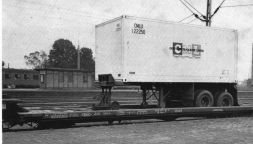
Abb. 1. Ein 20'-Container mit Kraftfahrzeug-Chassis auf einem DB-Niederflurwagen der Gattung SSis 60 („Aachen“).
