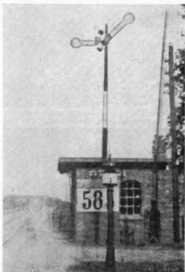
Abb. 5. Zwillings-Signal aus dem Jahre 1920, das mit dem aus Lübeck starke Ähnlichkeit hat. Der Lokführer hatte nur das Signal zu beachten, das für seine Fahrtrichtung galt. An dieser zweigleisigen Strecke war also gleichzeitig eine „Fahrtrichtungsfrei“-Stellung beider Flügel möglich. Repro aus dem „Katechismus für Bahnwärter“ von J. Stumm, Braubach.
