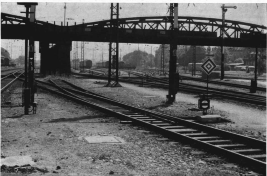
Abb. 1. Schutzweiche im Hbf. Freiburg/Brsg., deren Laterne gleichzeitig als Sperrsignal fungiert (vermutlich zur Sicherung des Durchgangsverkehrs gegen seitliche Rangierfahrten). (Foto: D. Bodek, Frankfurt)
