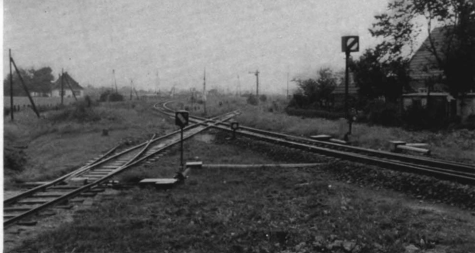
Abb. 2. Schienengleiche Kreuzung der Auricher Kreisbahn (1 m-Schmalspur) und der DB-Strecke Wilhelmshaven-Norden vor dem Bahnhof Esens. Die DB-Strecke ist mit Flügelsignalen und Schutzweichen im Schmalspurgleis gesichert. (Foto: N. Illgen, Wiesbaden)
