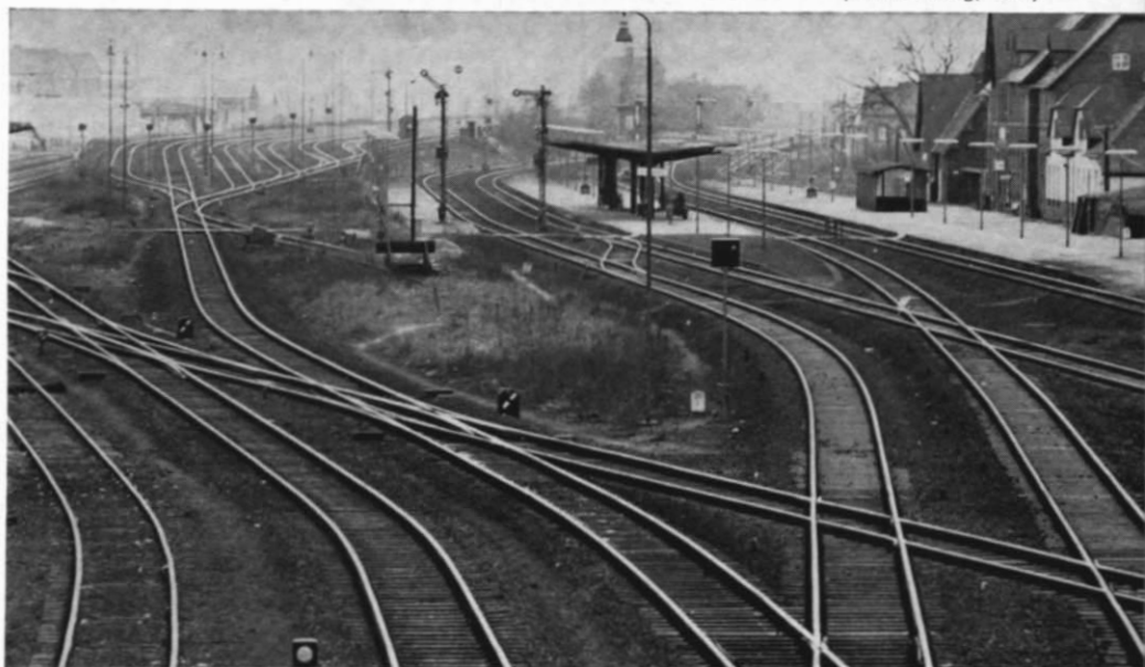
Abb. 5. Geradezu ein klassisches Beispiel für eine Schutzweichen-Anordnung (incl. Prellbock) als Abschluß einer Gleisharfe im Bf. Ehrang/Mosel. (Foto: J. Zeug, Trier)
