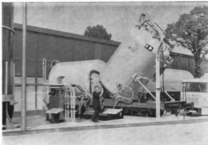
Abb. 2. Das Vorbild für das Puttlitz-Modell, über das wir seinerzeit während der Verkehrsausstellung in München „gestolpert“ sind und das wir damals vorsorglicherweise schnappgeschossen haben. Die Behälter (mit 56 m 3 und 80 m 3 Volumen) sind bis zu 45° kippbar.
