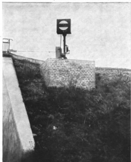
Abb. 3. Bei diesem Vorsignal wird die Erdaufschüttung durch waagrecht liegende Bohlen (alte Schwellen) gehalten, und diese ihrerseits wieder durch zwei senkrecht eingerammte Bohlen. Durch diese „Konstruktion“ wirkt der Podest irgendwie interessanter als die in Abb. 1 und 2 oder gar ein glatter Betonklotz. (Foto: E. Thomas, Gütersloh)
