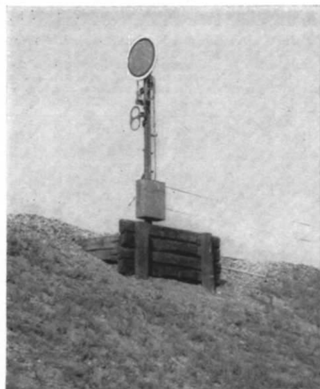
Abb. 3. Bei diesem Vorsignal wird die Erdaufschüttung durch waagrecht liegende Bohlen (alte Schwellen) gehalten, und diese ihrerseits wieder durch zwei senkrecht eingerammte Bohlen. Durch diese „Konstruktion“ wirkt der Podest irgendwie interessanter als die in Abb. 1 und 2 oder gar ein glatter Betonklotz. (Foto: E. Thomas, Gütersloh)
