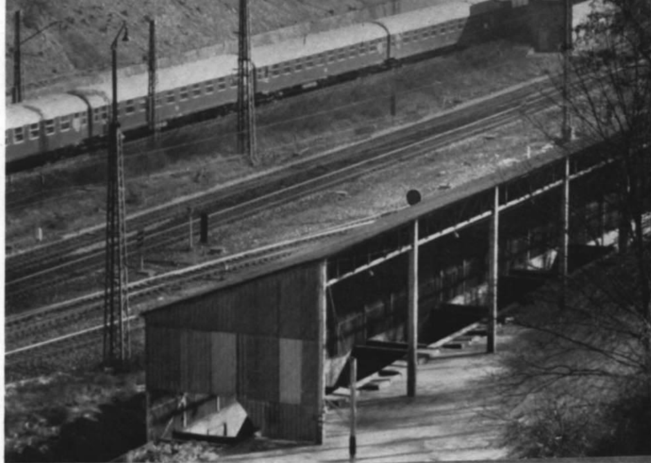
Abb. 5. Rückseite der Verladeanlage. Am Dachfirst die Fachwerkkonstruktion mit den Beleuchtungskörpern. Im Boden sind die abgekanteten Bleche zu sehen, die verhindern sollen, daß Müll zwischen Rampe und Güterwagen fällt. (Im Hintergrund der F-Zug „Rheinblitz“ F 28 auf dem Ferngleis).
