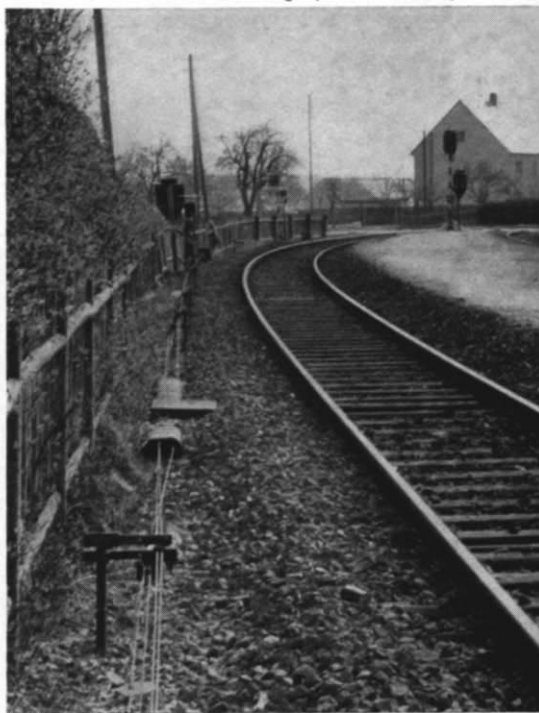
Abb. 2. Drahtzüge längs des Schienenstrangs. (Foto: R. Frieber)
