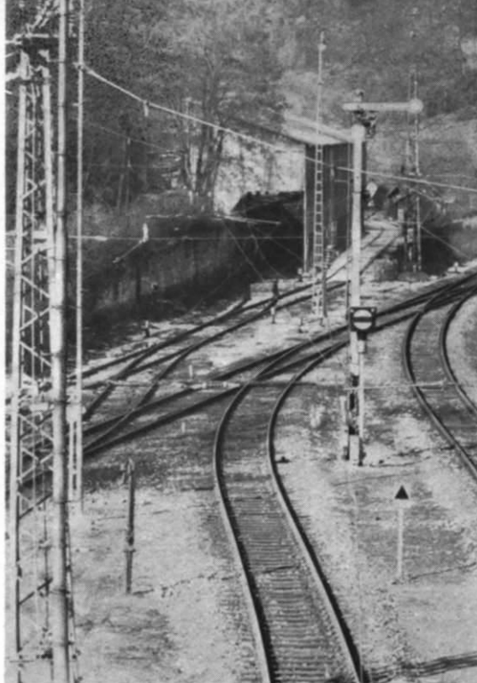
Abb. 1. Die Verladeanlage, von der Stirnseite betrachtet. Für die Verschiebe-Lokomotive sollte ein Umfahrgleis vorhanden sein. Das Ladegleis ist mit einer Gleissperre abgesichert.
