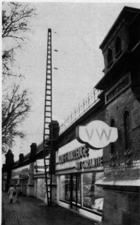
Abb. 11. In der Hamburger Dammtor-Gegend hat man die leichteren Maste auf die Straße gestellt und in derselben sowie an der Damm-Mauer verankert. (Foto: Zeug, Trier)
