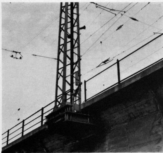
Abb. 13. In Geislingen (Steige) sind stabile I-Träger in die Betonmauer eingelassen, auf denen der Mast befestigt ist. (Foto: P. Fuchs, Berlin)
