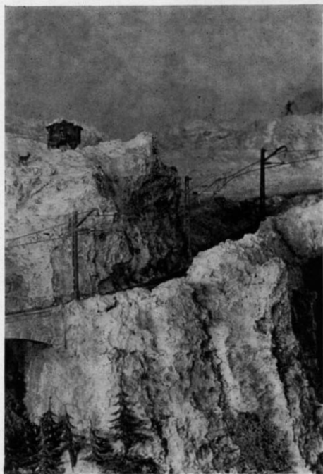
▼ Abb. 19. Abändern der Fahrleitungen entsprechend dem Steigungswinkel der Bergstrecke.
