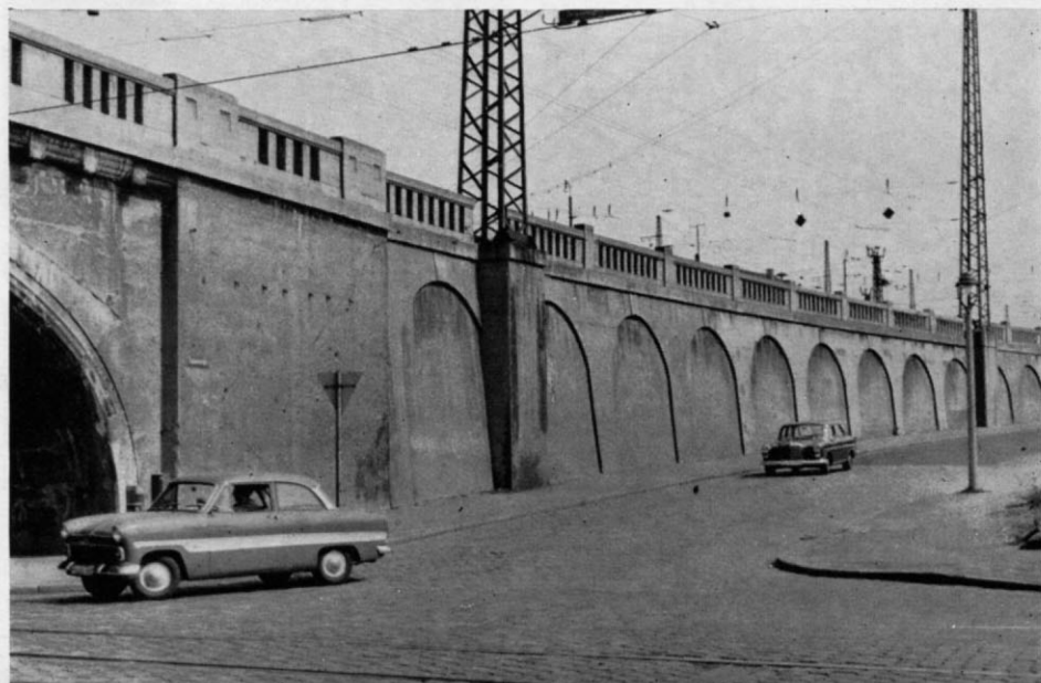
Abb. 8. In des Wortes wahrster Bedeutung: „Bogen — durch die Stadt gezogen“. Ausgemauerte Bogen und Mastsockelanbringung im Stadtgebiet von Nürnberg. Man beachte auch das steinerne Schutzgeländer, das mit der Damm-Mauer ein harmonisches Ganzes bildet. (Foto: GERA)
