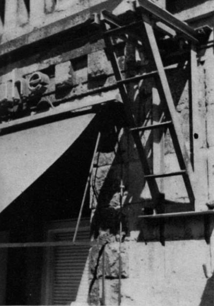
Abb. 12. Diese Tragkonstruktion am Hochdamm in Hannover ist aus U- und L-Eisenprofilen zusammengesetzt. (Foto: B. Rose, Hannover)
