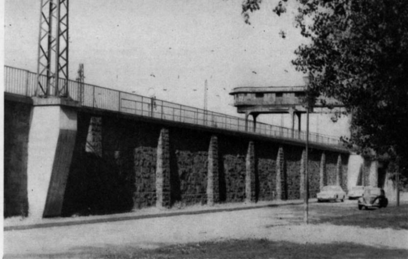
Abb. 9. Ein in mehrfacher Hinsicht interessantes Bahndamm-Motiv aus Düsseldorf (Ausfahrt Süd): u. a. die durch Pfeiler aufgelockerte Bruchsteinmauer sowie die Fundamente für die Turmmaste, die in Sichtbeton an die Wand gesetzt wurden. (Foto: K. Baumgarten, Düsseldorf)
