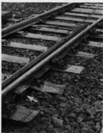
← Abb. 12. Rechts (an der Außenseite der Flügelschiene) der Kabelübergangskasten; an der Innenseite der Schiene sind die auf dem Schienenfuß aufliegenden Heizstäbe n zu sehen, die den Zwischenraum zwischen Zunge und Backschiene eis- und schneefrei halten. (Fotos Abb. 8-12: K. J. Ehrngruber, Münster)
