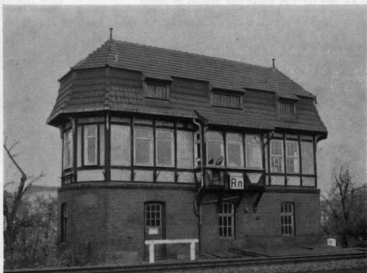
Abb. 8. Ansicht „Straßenseite“, die es eigentlich nicht gibt, s. Abb. 12, (= Rückseite) und Stirnseite Süd in \frac{1}{2} H0-Größe (Zeichnungen: R. Frieber, MIBA-Verlag). An der Rückseite hat das Stellwerk-Stockwerk keine Fenster (s. Abb. 11). Beachten Sie, daß die Abschrägungen der Stirnseiten unterhalb der Dammkrone in eine spitze Kante auslaufen. Höchst interessant, aber auch etwas knifflig: der Erkervorbau an der Vorderseite.
