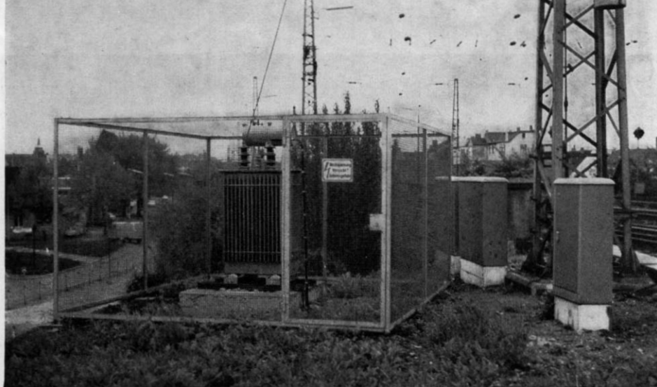
Abb. 10. Die Trafostation (Osnabrück), gegen Berührung durch einen Käfig aus Maschendraht gesichert. Die Einspeisung der Freileitung (c) ist deutlich zu sehen; vom Isolator rechts daneben führt die Stromrückleitung an die geerdete Schiene des nächsten Gleises. In den außerhalb des Käfigs stehenden Niederspannungsverteilsschränken sind die Teile h, i und k installiert.
