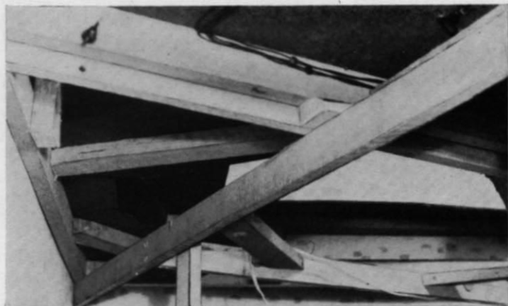
Abb. 2. Ebenfalls gut und richtig: das Verbinden zweier Rahmengestelle mittels Flügelschrauben. Bei der offenen Rahmenbauweise wird man nämlich leicht dazu verleitet, sämtliche Latten und Leisten zu einem einzigen Gerüst zusammenzufügen, statt auch hier — vorsorglicherweise — kleinere Gerüsteinheiten anzufertigen und, wie hier gezeigt, zusammenzuschrauben. Diese Aufteilung der Anlage in mehrere kleinere Einheiten ist besonders angeraten, wenn man mit einem Wohnungswechsel rechnen muß!
