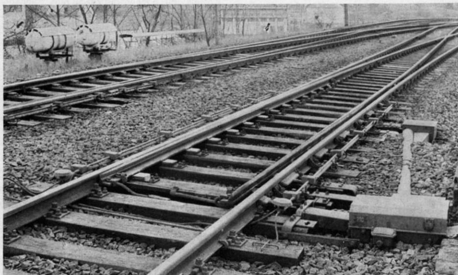
Abb. 6. Diese offenbar ebenfalls propangas-beheizten Weichen entdeckte Herr J. Zeug, Trier, in der Nähe von Ehrang. Deutlich zu sehen: die Standard-Gasbehälter gemäß der Skizze Abb. 3 und daneben ein überdachtes Schutzgestell (für das wir allerdings keine Erklärung haben). Modellbahnanlagen mit gebirgigem Charakter sollten zumindest in den Hauptgleisen Weichen mit Beheizungsattrappen aufweisen! Weitere Konstruktionsdetails gehen aus Abb. 4 und 7 hervor.
