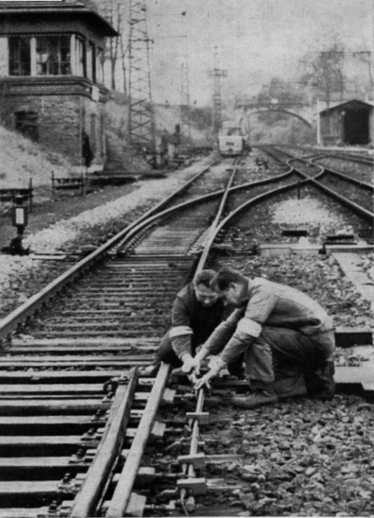
Abb. 7. Zwei Arbeiter bei der Montage der Propan-gas-Heizeinrichtung an einer Weiche. Die Gasbrenner sind unmittelbar an der Schiene zu erkennen.
