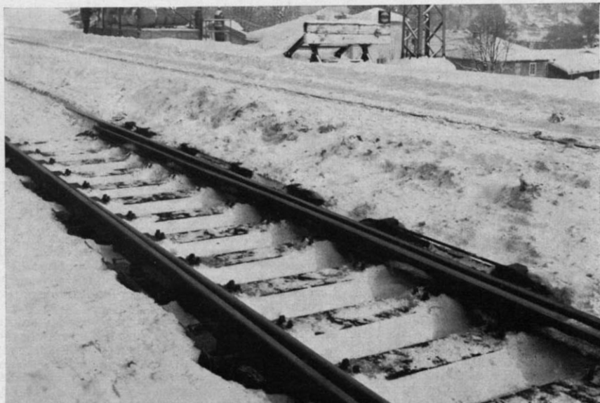
Abb. 1. Besser und eindringlicher läßt sich die Wirkung der Weichenheiz-Anlagen kaum demonstrieren: trotz der dichten Schneedecke sind die beweglichen Weichenteile frei. Im Bildhintergrund eine Anzahl von Gasbehältern. (Werkfoto: Pintsch-Bamag)
