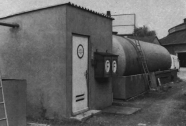
Abb. 27. Das Tanklager von der Gleis- seite aus gesehen. Man beachte die auf eingefallenen Fundamenten ruhenden dünnwandigen Öl-Auffangwannen.
