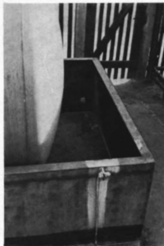
Abb. 29. So sieht eine Öl-Auffangwanne aus: ein dünnwandiges geschweißtes Blechgehäuse mit einem Verstärkungs- rahmen aus Winkelprofilen.
