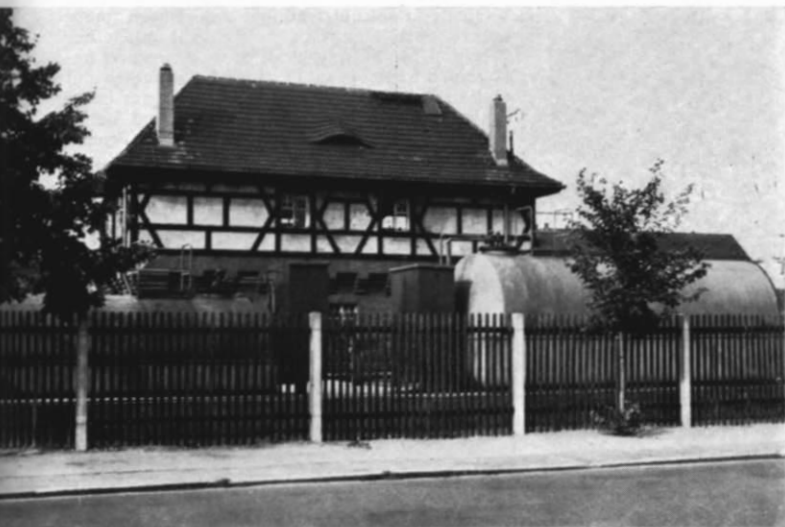
Abb. 30. Die Dieseltankstelle im Bf. Fürth/Bay. ist ein beredtes Beispiel dafür, daß eine solche Tankanlage keineswegs besondere Platzansprüche stellt, sondern ggf. auf einem bislang ungenutzten Anlagenflecken installiert werden kann. In Fürth liegt sie beispielsweise in Höhe des Stellwerkes Ost direkt hinter dem Zaun, der das Bahngelände von der Straße trennt (s. a. Abb. 5, S. 594 in Heft 12/XIX).
