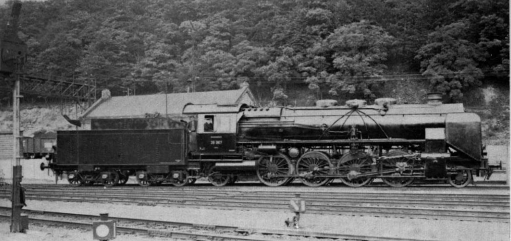
Abb. 8. Wuchtig und kraftvoll wirkt die BR 39 — die letzte und schwerste preußische Schnellzuglok (erstmalig im Jahre 1922 von Borsig gebaut). Durch ihre Höchstgeschwindigkeit von 110 km/h konnte sie — neben der Beförderung schwerster Personenzüge bis zu 60 Achsen — auch für den Schnellzug- und Eilgüterzugdienst herangezogen werden. Die „39“ wurde in drei verschiedenen Bauformen und einer Sonderbauform mit Versuchs-Steuerung (39 230) gebaut. (Foto: Lokbildarchiv Bellingrodt)
